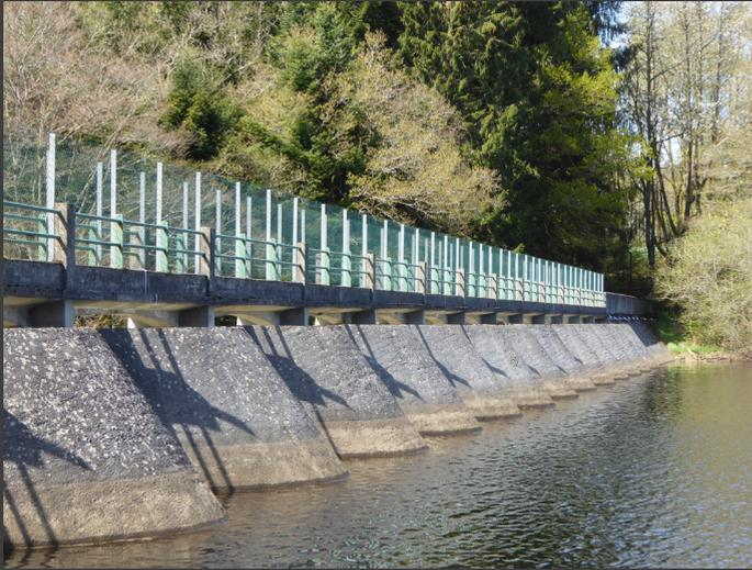
Le barrage côté réserve d'eau, succession des voûtes en béton
