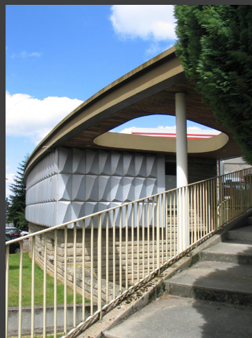
Habillage modulaire du bâtiment de la station
