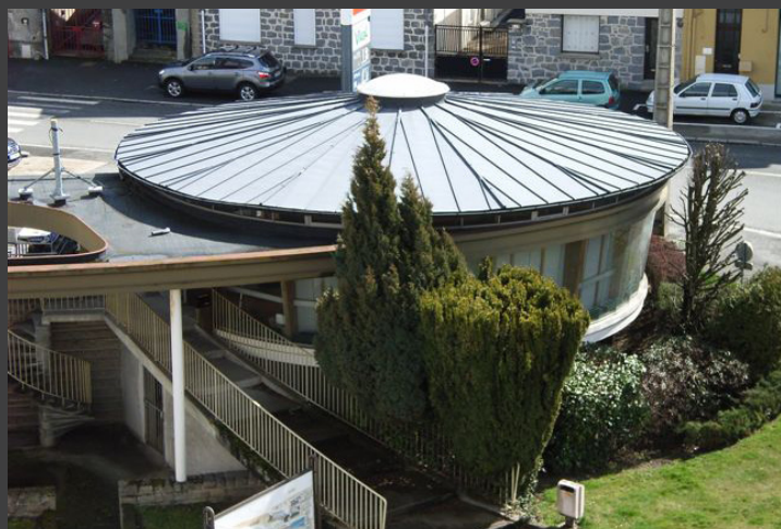
La rotonde et sa couverture radiale en zinc
