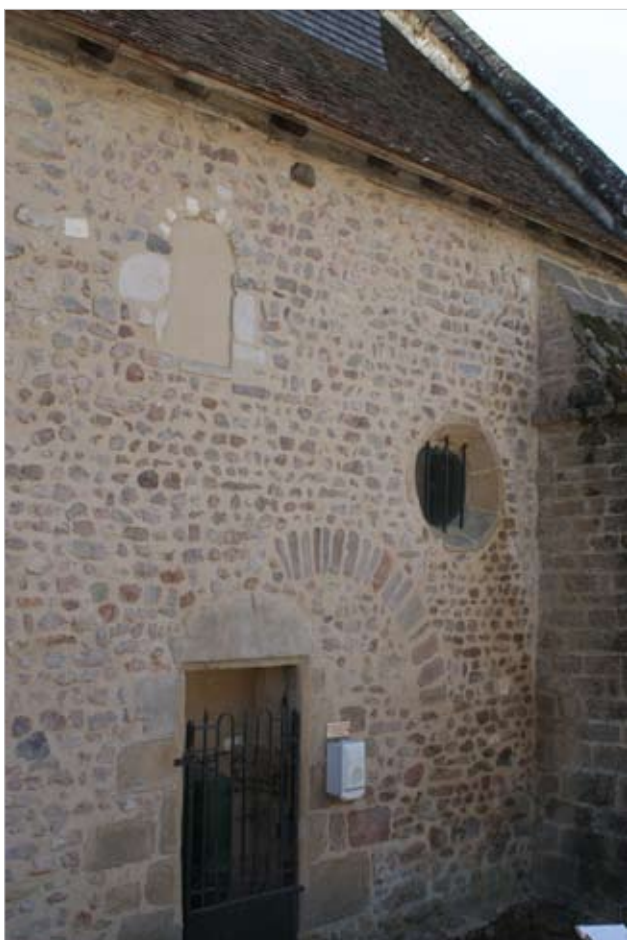
Fig. 2 : façade nord de la nef avec des éléments d'une ouverture et d'une baie associées au petit appareil. Cl. Jacques Roger
