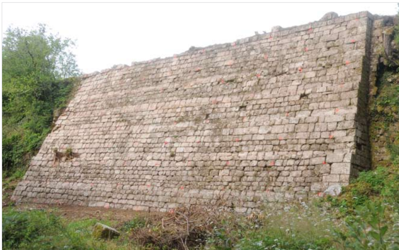
Fig. 1 : l'avancée de la terrasse orientale
