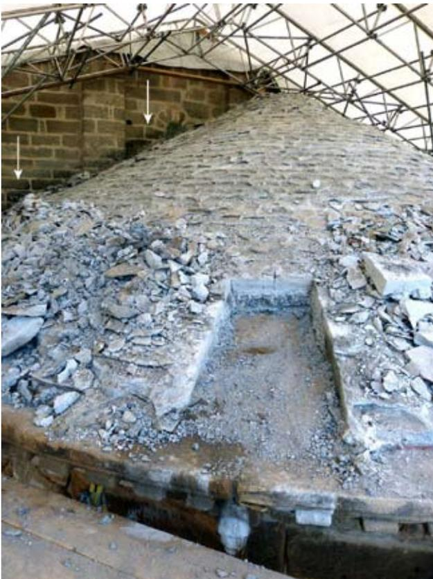
Fig. 1 : couverture en béton et lauzes (déposées) de l'abside du chœur - Emplacement du sondage (flèches) - Vue depuis le nord-est. Cl. E. Bouticourt, Archeodunum
