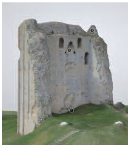
Figure 7 : La tour de Broue, face intérieure : en 1 le niveau inférieur de la tour, en 2 la cheminée, et en 5 la salle d'accès au chemin de ronde (?) (DAO : B. Guillot).
