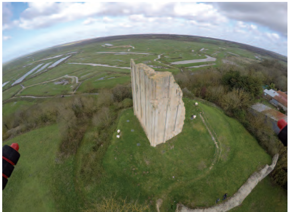
Figure 4 : La tour de Broue, vue générale du site : en 3 les vestiges de la courtine occidentale et en 4 la plate-forme nord (DAO : B. Guillot).
