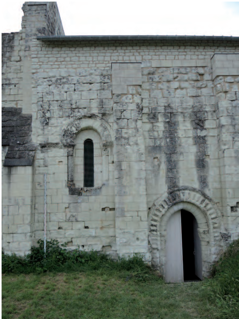
Figure 7 : Scorbé-Clairvaux, élévations nord de la chapelle au point de raccord de la nef (Cliché : P. Bouvart).
