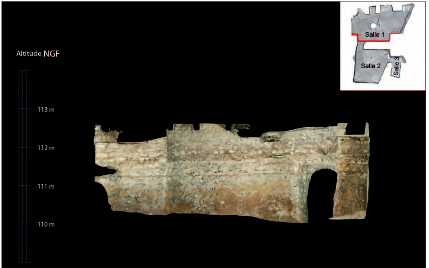
Poitiers - 10 rue des Arènes Romaines - Orthophotographie Salle 1 - Fondations des piliers d'arcs et du mur rayonnant entre les travées 13 et 14.
