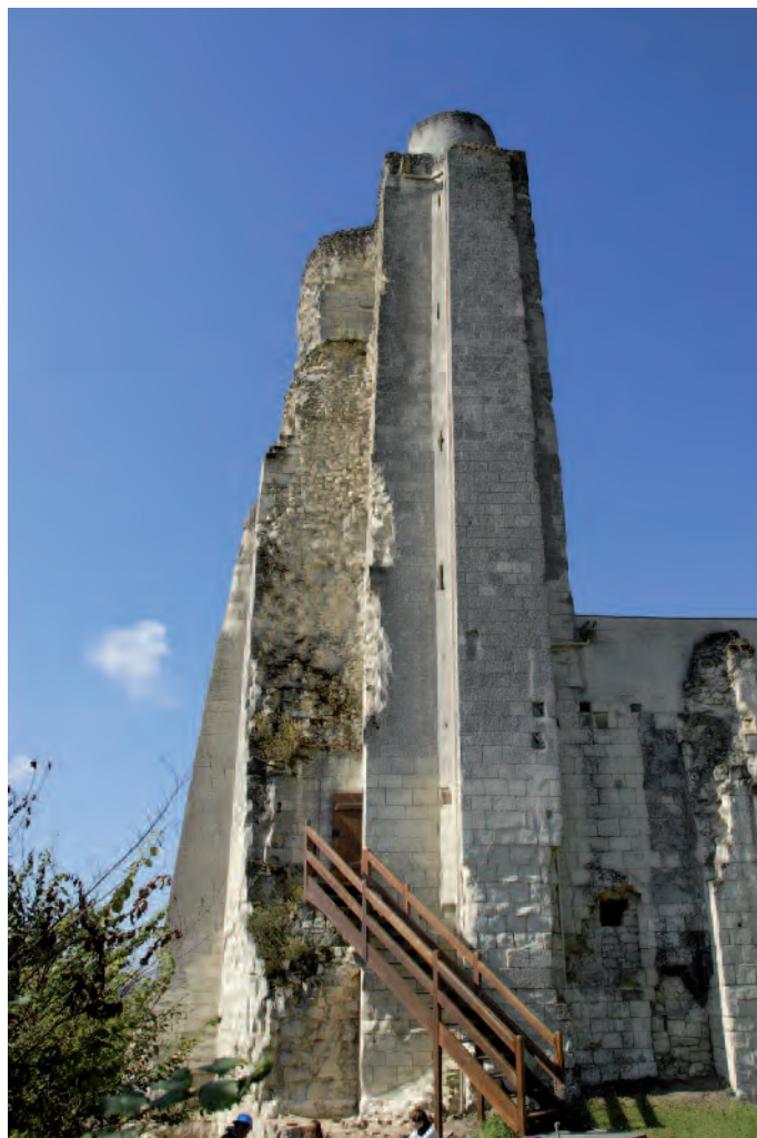
Figure 3 : Scorbé-Clairvaux, vue générale de la façade nord de la tour-maîtresse du Haut-Clairvaux (Cliché : N. Prouteau).
