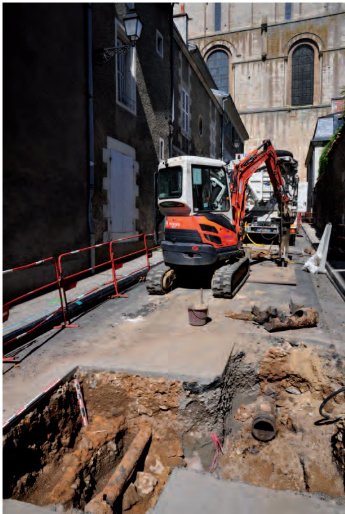
Poitiers, 11 rue Arthur de la Mauvinière, vestige d'un mur gallo-romain (Cliché : C. Belliard).
