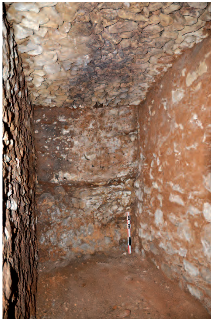
Poitiers, 10 rue des Arènes romaines, salle 3 : détail du radier de fondation du tronçon situé sur le tracé du 7e mur annulaire (Cliché : C. Belliard).
