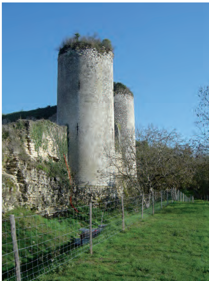
Figure 1 : Échiré, vue générale de la tour du moulin depuis l'ouest en 2005 (Cliché : A. Montigny)
