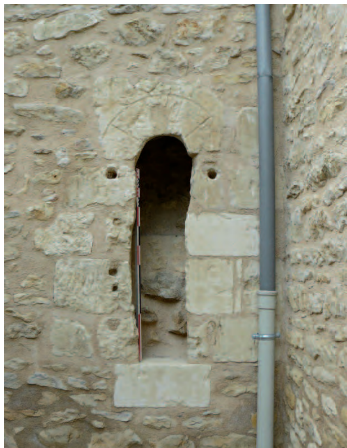
Saint-Jouin-de-Marnes, linteau de fenêtre, incisé de faux-claveaux (Cliché : Hadès).
