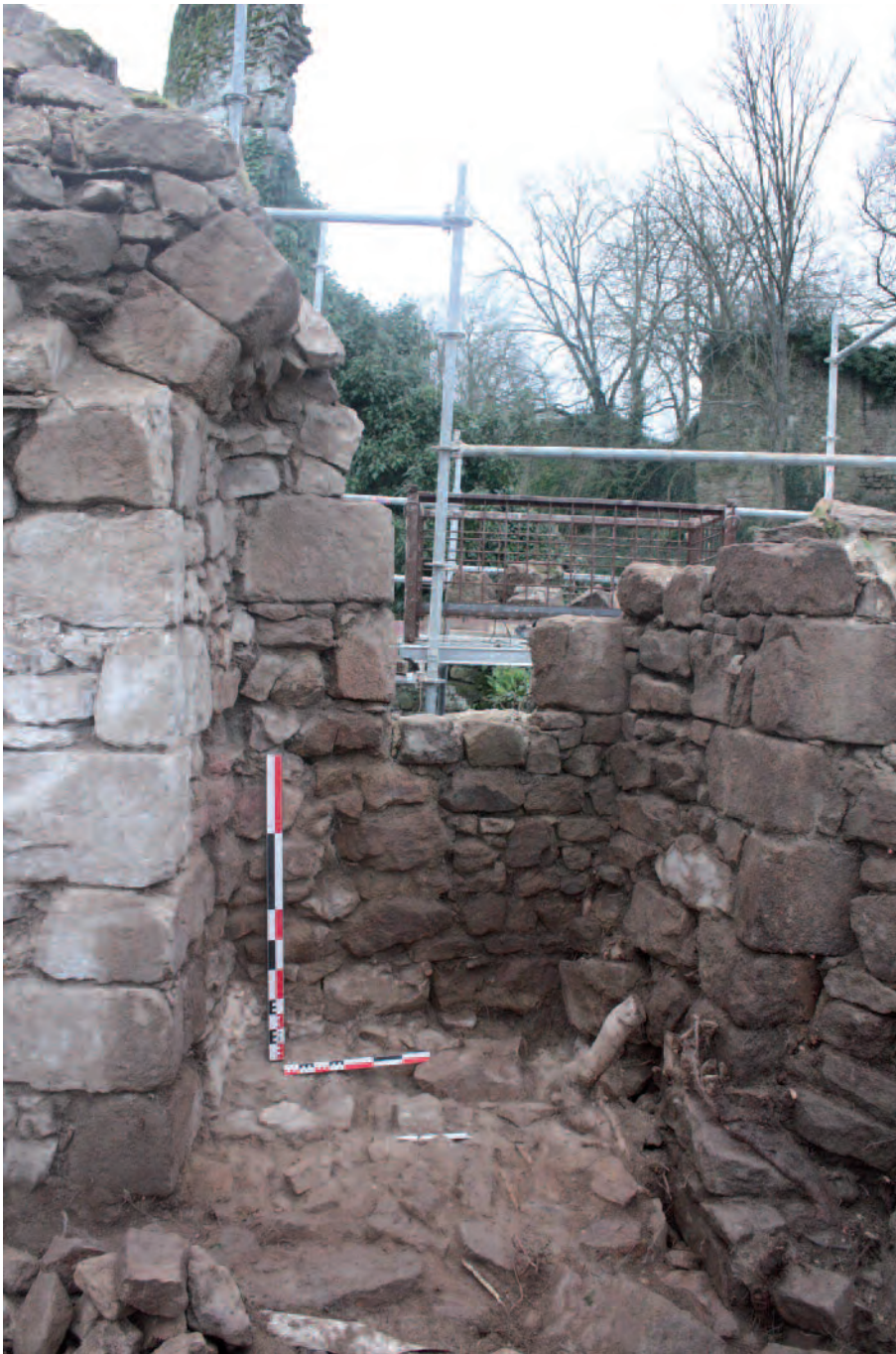
Figure 2 : Bressuire, vue de l'archère sud-est de la tour 39. (Cliché : F. Mandon).
