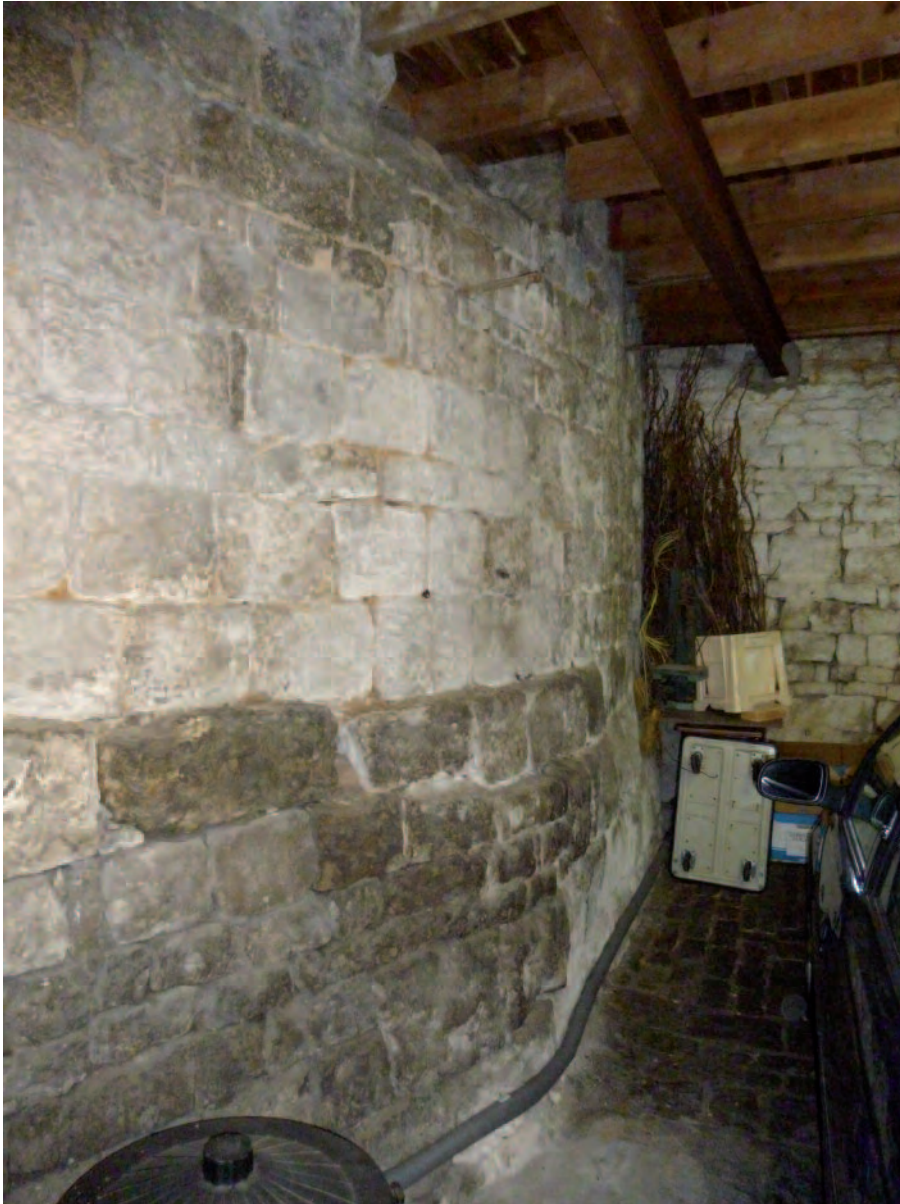
Melle, centre ville, base de remparts (Cliché : E. Lacroze)
