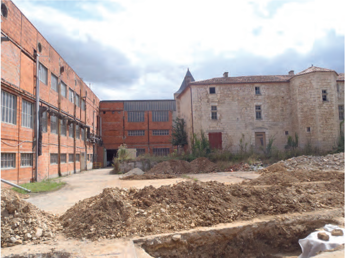
Figure 2 : La Rochefoucauld, vue partielle du logis prieural dans son environnement industriel (cliché : Inrap).
