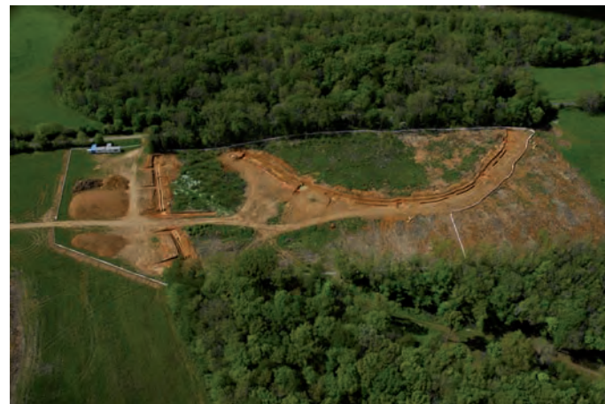
Fig. 9 : Section de l'aqueduc de Fleury fouillée à Vouneuil-sous-Biard (Vienne), (cliché : A. Ollivier, 2012).
