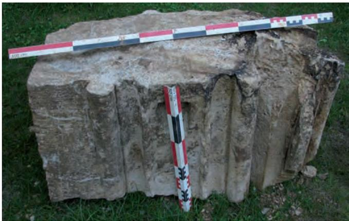
Figure 2 : Celles-sur Belle, fragment de nervures d'une voûte couvrant la galerie occidentale du cloître (Cliché : P. Bouvart).
