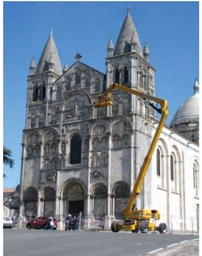
Figure 2 : Angoulême, vue générale de la façade en cours d'étude (Cliché : Hadès).
