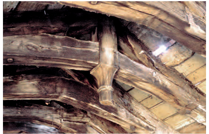
Niort, hôtel Saint-Vaize : charpente apparente du XIIIe s. au premier étage du bâtiment 1, détail du poinçon (cliché : L. Prysmicki).
