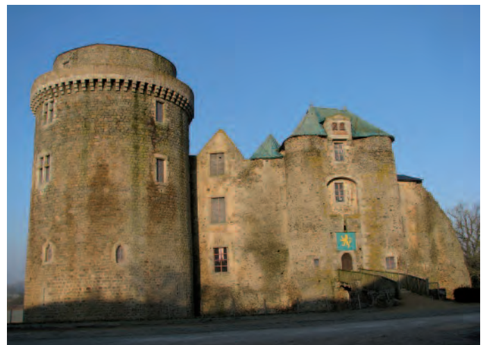
Saint-André-sur-Sèvre, château de Saint-Mesmin : élévations extérieures orientales avec la tour maîtresse à gauche (cliché : P. Bouvart).
