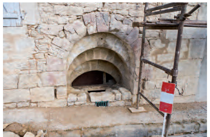
Charroux, maison romane : descente de cave sur la rue à arcs successifs (XIIe siècle). Remarquer les pierres rubéfiées par un violent incendie (cliché : L. Prysmicki).
