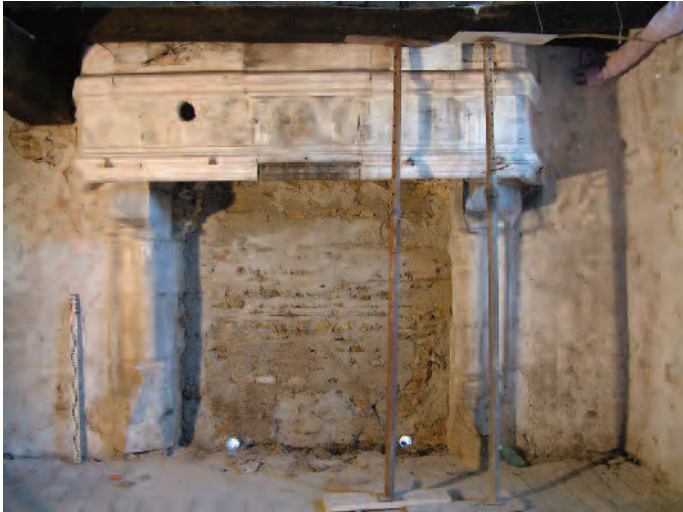
Valdivienne, maison Rochefort, 15 rue de l'Aumônerie à Morthermer : cheminée à l'étage (cliché : P. Bouvart).
