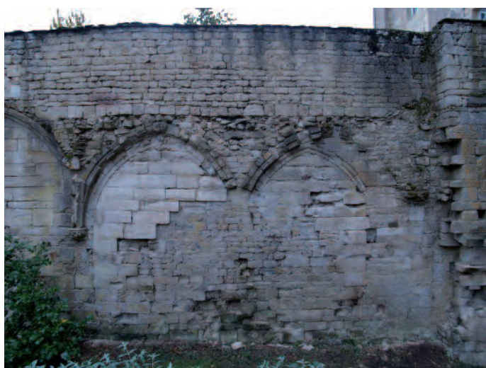
Celles-sur-Belle, bâtiments conventuels de l'abbaye : vestiges de la galerie orientale du cloître (cliché : P. Bouvart).
