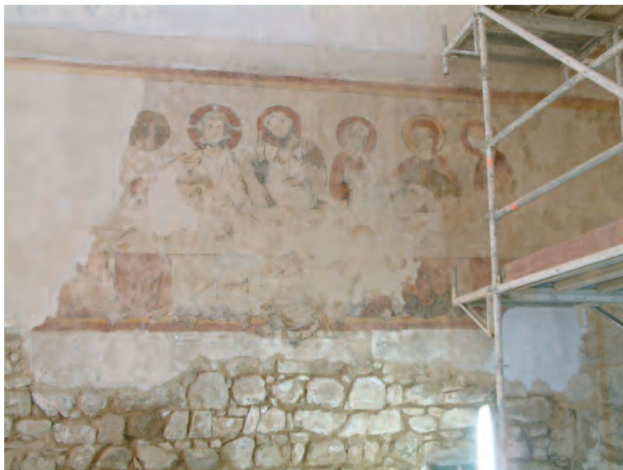
Saint-Clémentin, chapelle Sainte-Marie-des-Rosiers : enduit peint dans la nef figurant la Cène (cliché : P. Bouvart).
