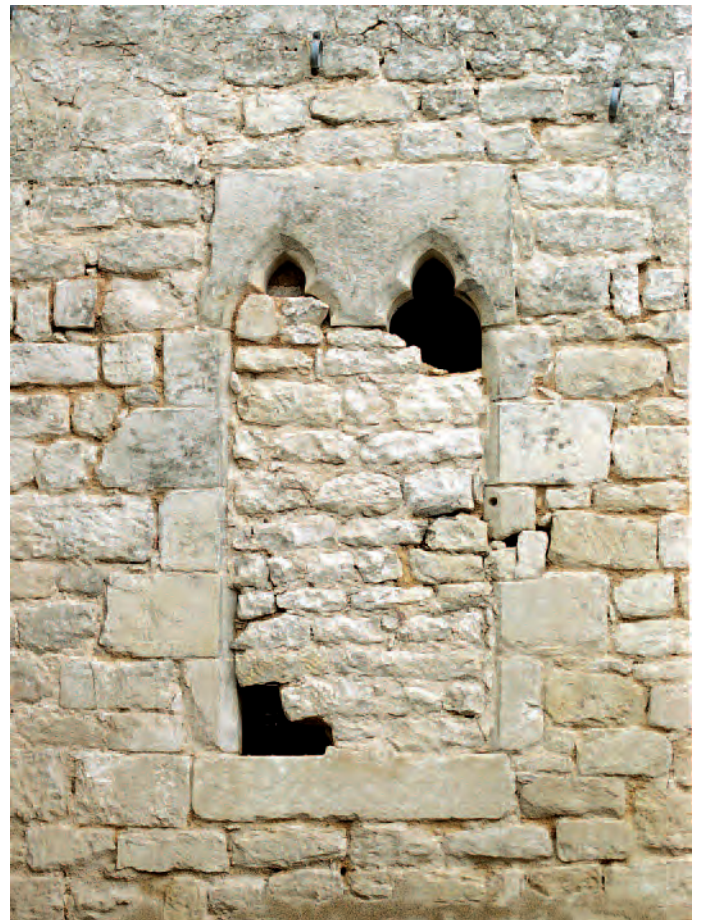
Niort, hôtel Saint-Vaize : façade sud-ouest du bâtiment 1, fenêtre géminée du XIIIe s. au premier étage (cliché : L. Prysmicki).
