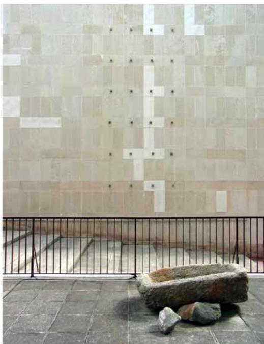
>>> Par endroits, le remplacement d'éléments du revêtement d'origine du mur (pierre banchée) est parfaitement visible, faute d'avoir pu retrouver les mêmes pierres que celles utilisées par Fernand Pouillon.
