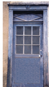
porte vitrée avec imposte
