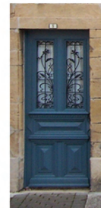
porte vitrée avec ferronneries
