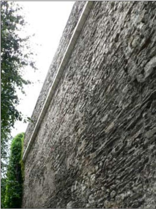
Fig. n° 16 – Vues de la corniche en tuffeau supportant le parapet (XVe-XVIe siècle), rue Toussaint. Phot. F. Comte.
