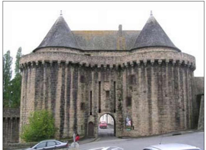
Figure 15 : Hennebont – porte Broërec (photographie de mars 2008). Les rainures et les feuillures des deux ponts-levis à flèches sont nettement perceptibles.
