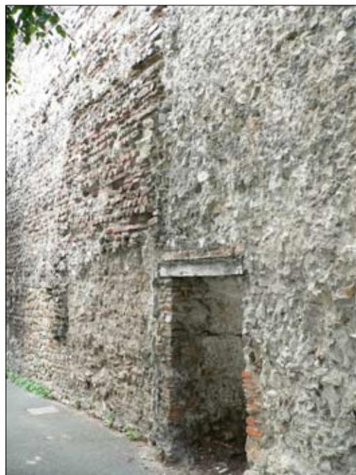
Fig. n° 23 – Traces des destructions du parement de l'enceinte, rue Toussaint : placard-alcove et niche. Phot. F. Comte.
