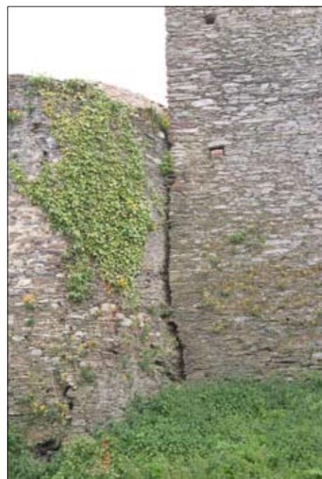
Figure 4 : Pouancé, type d'appareil de schiste majoritairement employé sur le château (cl., Anaïs CASAUBON, 2010)
