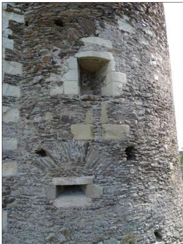
Fig. 11 : Détail de l'élévation extérieure de la tour 2 avec la reprise de la canonnière du niveau 2 (UA 511 et 512) (SADML)
