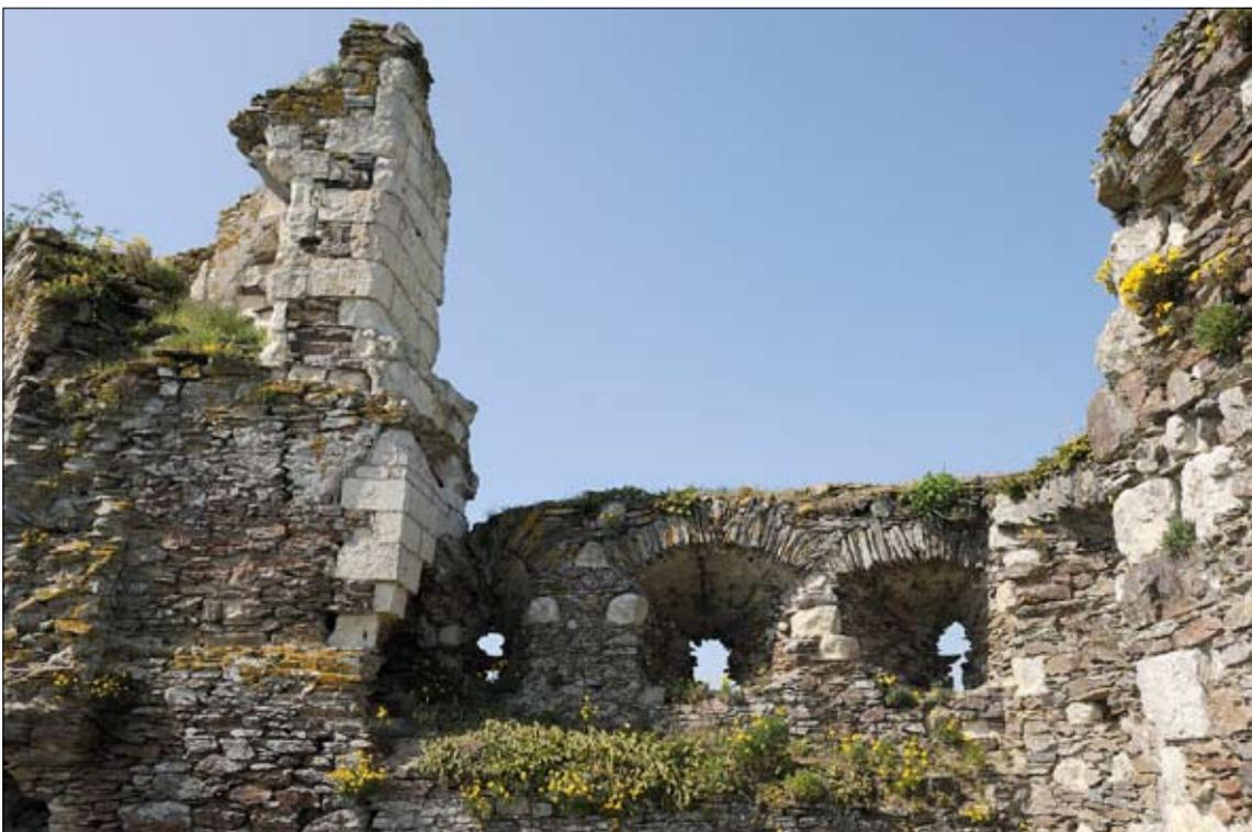
Fig. 8 : Tour 2, vue des jambages sud de deux baies superposées liée à l'UA 528, recoupées lors de la reconstruction du châtelet (UA 511) (cl. B. Rousseau, Service Départemental de l'Inventaire).
