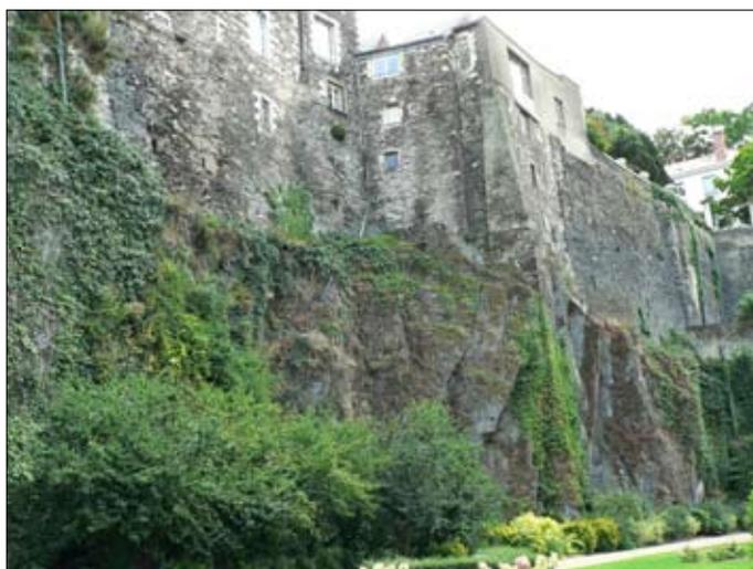
Fig. n° 9 – L'aplomb rocheux, vue du côté Maine, sur lequel repose l'enceinte et des maisons canoniales, a servi de carrière jusqu'au XVIIIe siècle. Phot. F. Comte.
