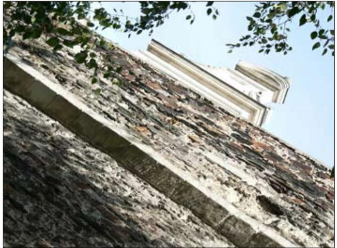
Fig. n° 17 – Vues de la corniche en tuffeau supportant le parapet (XVe-XVIe siècle), rue Toussaint. Phot. F. Comte.
