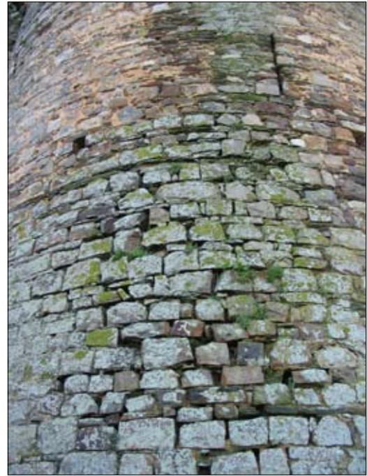
Figure 5 : Pouancé, Grosse Tour, appareil spécifique de grès et schiste (cl., A. CASAUBON, 2006)
