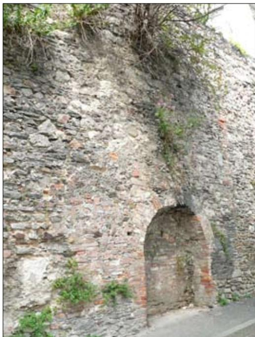
Fig. n° 22 – Traces des destructions du parement de l'enceinte, rue Toussaint : placard-alcove et niche. Phot. F. Comte.
