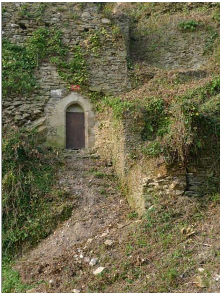
Fig. 13 : Vue de la poterne extérieure (UA 507) reperçée dans la courtine 1-11, et des aménagements défensifs réalisés en fond de fossé au pied de la tour 1 (SADML).
