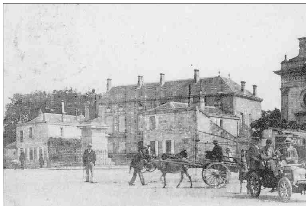
L'hôtel des haras (1819) sur les allées de la République (démoli pour construire le lycée) photo des années 1900
