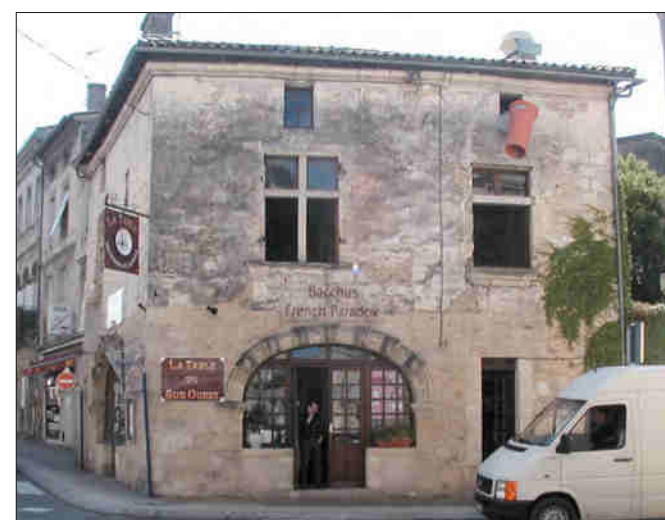
Les «Démons de Bacchus», rue Fonneuve (l'ouverture en arc visible sur la photo n'est pas d'origine; seule celle que l'on aperçoit à gauche est d'époque).
