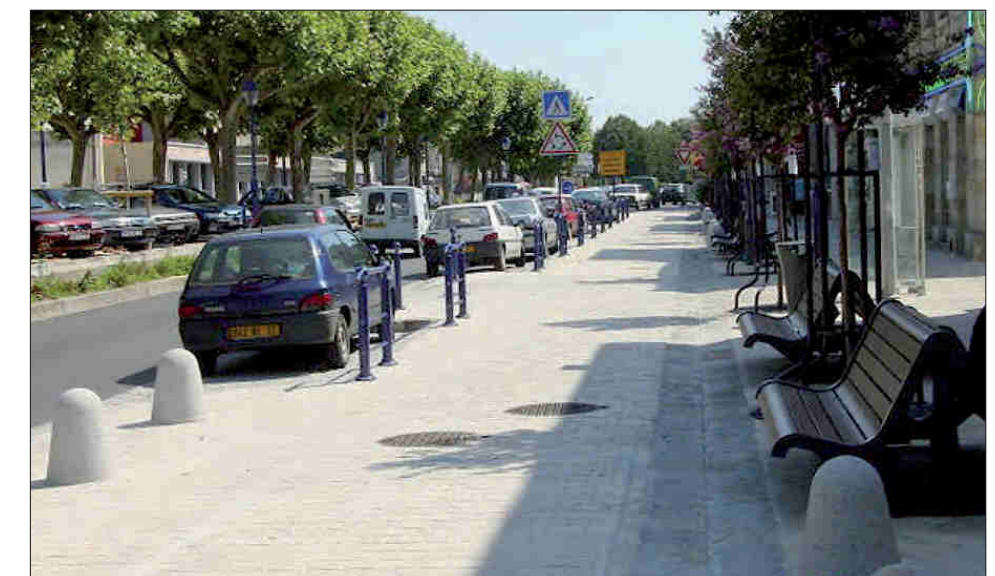
aménagement des allées Robert Boulin, 2001
