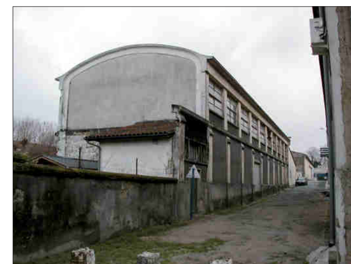
hangar industriel rue Rivière
