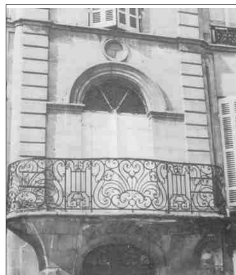
détail d'un balcon sur trompe
