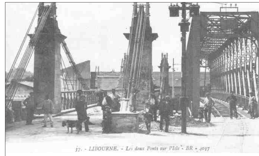
Pont du tramway sur l'Isle
