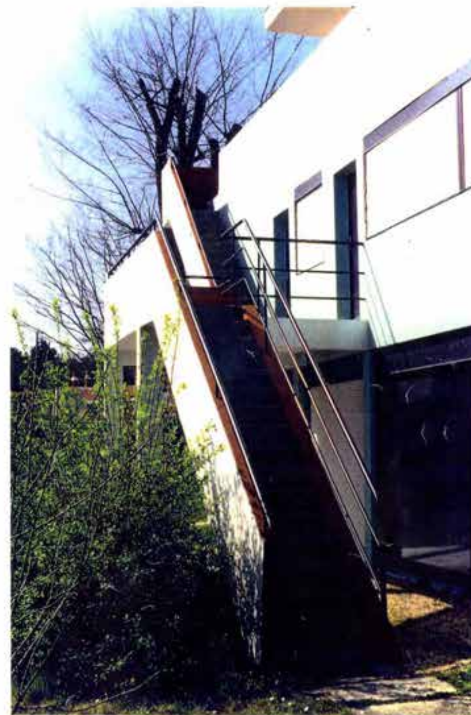
Maison VRINAT-BIDOLET. Restauration, 1992
