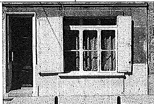
L'art nouveau s'exprime sur les menuiseries par l'arrondi des assemblages
