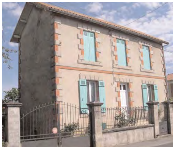
Construction en ciment et effet décoratif avec placage de briques
