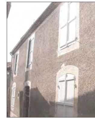
Ouverture : arc segmentaire du linteau en rez-de-chaussée et linteau droit à l'étage (rue Dausménil)
