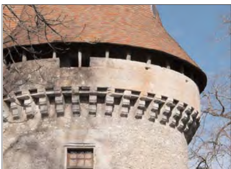
Chemin de ronde appuyé sur les corbeaux de mâchicoulis
