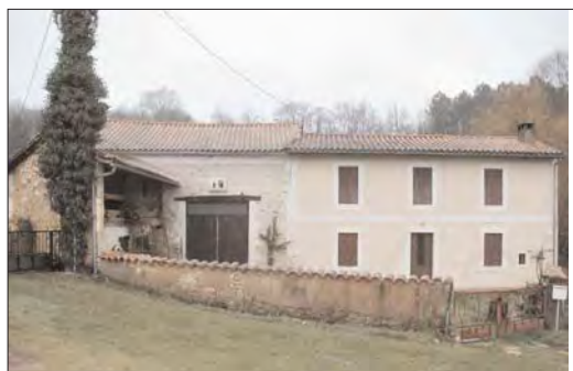
Enduit sur la partie habitation et pas sur la grange ni le hangar, parcelle n°559 du hameau Fontaneau
