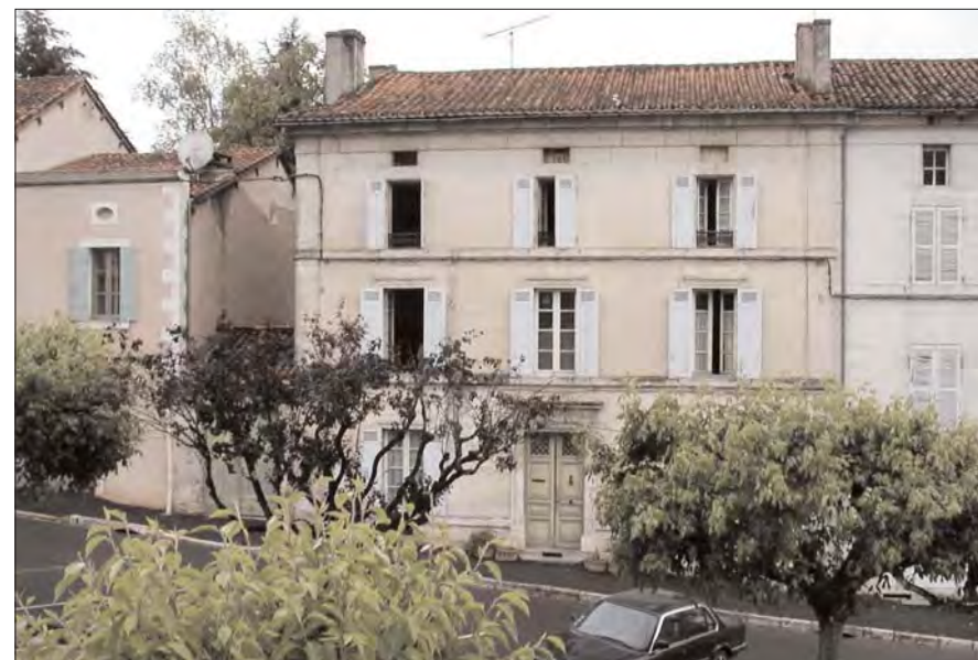
Façade en pierre de taille avec pilastres, bandeaux et encadrements moulurés, (Place du 14 juillet)
