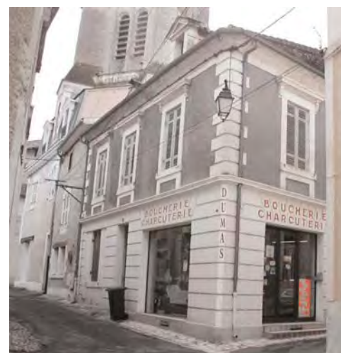
Rez-de-chaussée et chaînage en pierre de taille avec joints creux, ouverture du 1er avec encadrements et appuis saillants, entablement sur consoles, Lucarne en pierre ornée d'un fronton (Angle de la rue Talleyrand-Périgord et rue du Mal Bugeaud)
