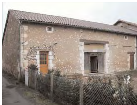
Maçonneries, parcelle n°340 du hameau La Borie
