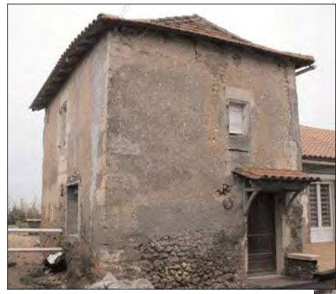
Débord de toiture avec chevrons, parcelle n°696 du Hameau Marland du Puy
