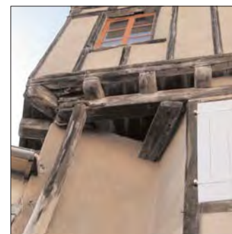
Détail du surplomb en pans de bois de la façade (rue de la Fontaine)
