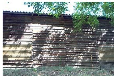
La structure constructive utilise souvent le poteau bois et la charpente, le mur n'est pas porteur comme dans l'architecture traditionnelle. Ainsi, le matériau de façade est un élément de remplissage, comme la brique creuse ou un bardage comme les planches de bois, matériau économique.
