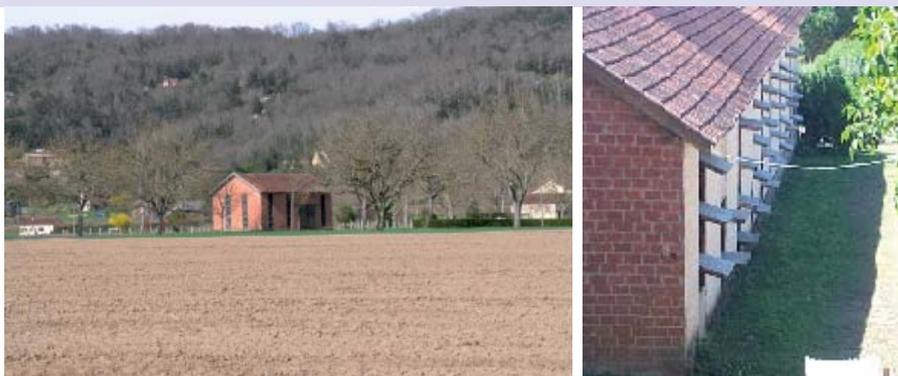
Séchoir à tabac en briques: le système des ouvertures pour la ventilation participe cette typologie particulière.
