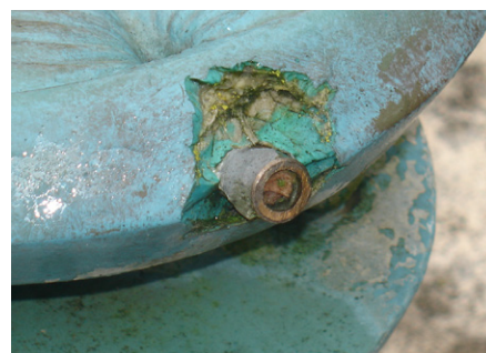
Détail des désordres sur la fontainerie d'une Petite tortue sur socle rond , tirage en résine de 1993.
