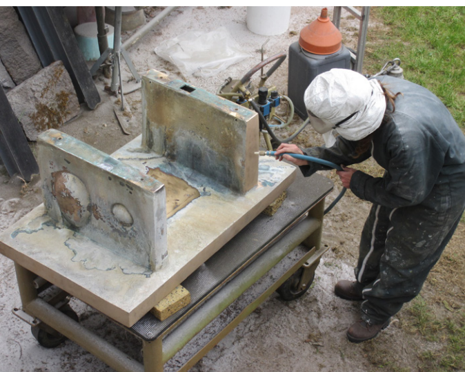
Fig. 6 : nettoyage plus poussé des croûtes calcaires.
