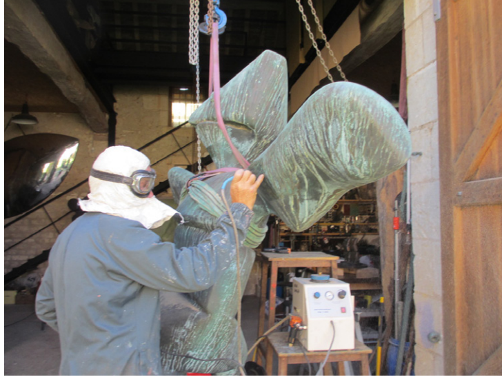
Fig. 5 : nettoyage sélectif par projection d'abrasifs végétaux.
