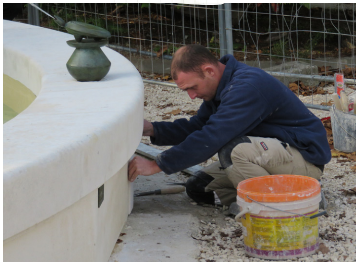
Derniers réglages de fontainerie avant remise en eau.
