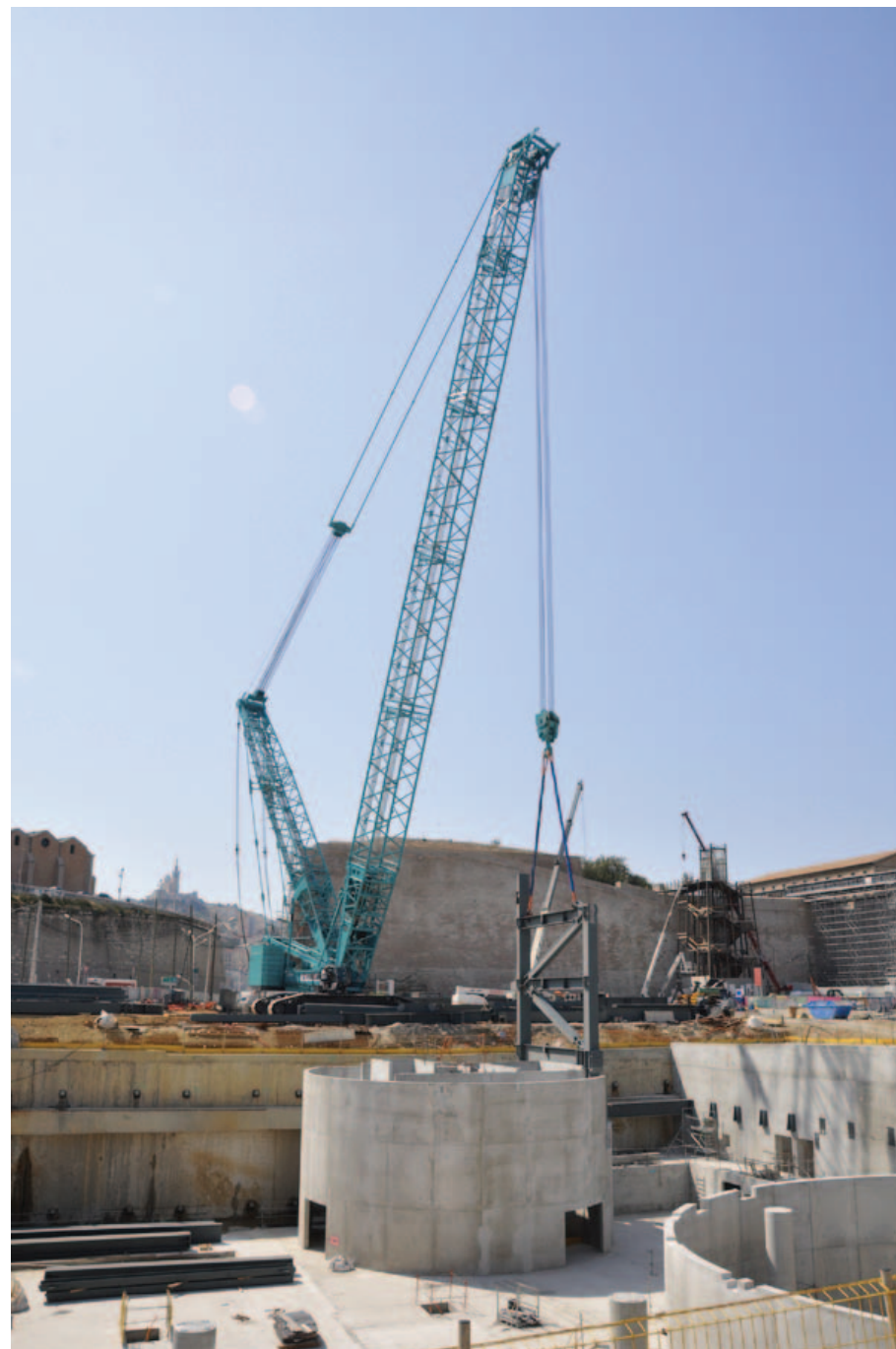
Chantier de la Villa Méditerranée. © Marc Pons / AREA PACA
