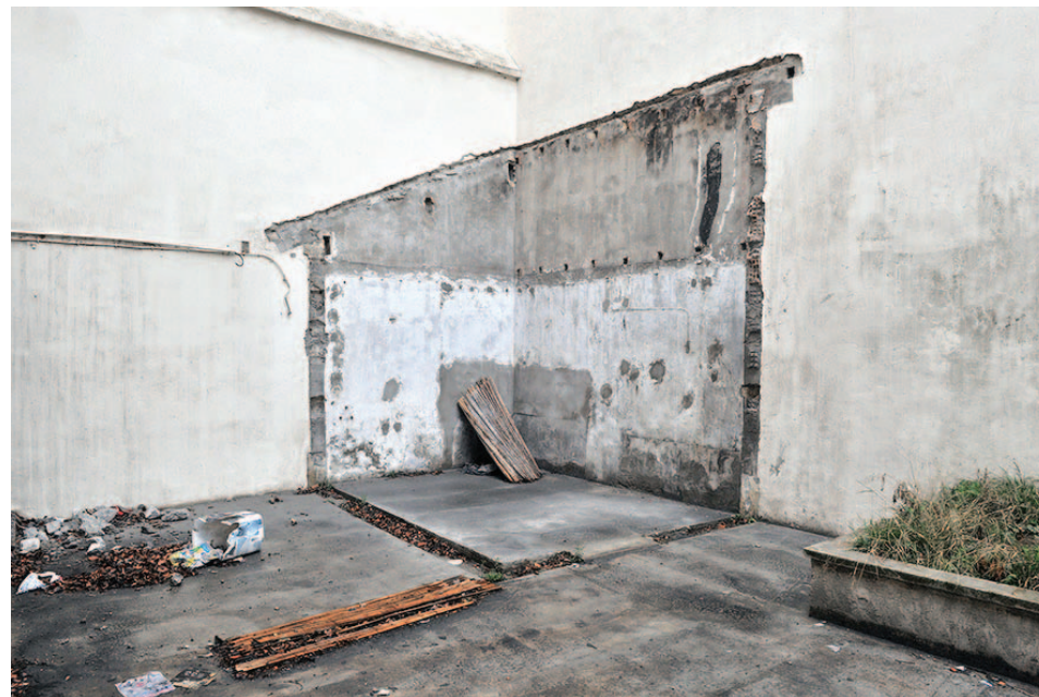
Chantier en cours avec traces d'une architecture passée. © Hervé Hôte
