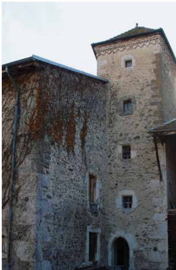
Ornex, vue générale de la tour.
