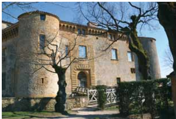
Bagnols, château. Vue générale de la façade occidentale et du portail à bossages donnant accès à la cour intérieure.
