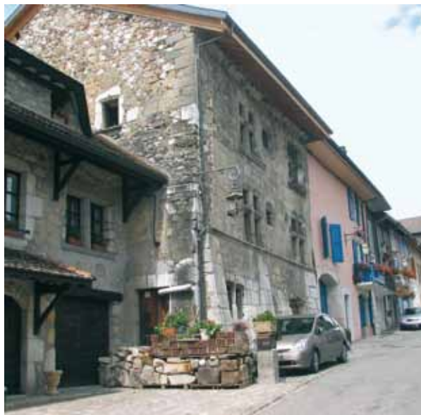
Cruseilles, maison de Fésigny. Vue générale depuis la rue.
