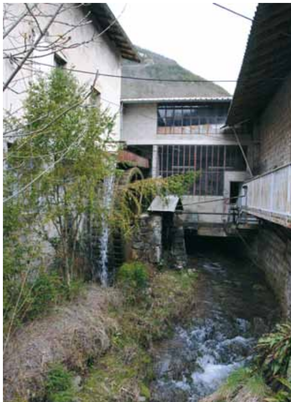
Cerdon, cuivrerie. Vue de la roue à aubes.
