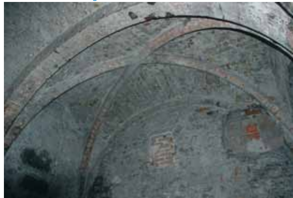
Grenoble, cathédrale Notre-Dame. Détail de la voûte d'ogives de l'ancien cloître.
