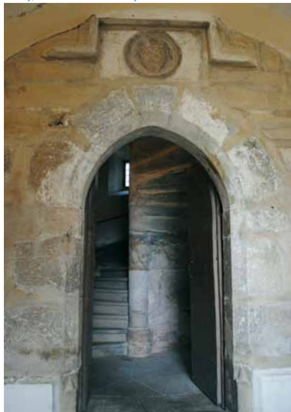
Boussy, maison forte de Mieudry. L'escalier en vis du XVI e siècle.
