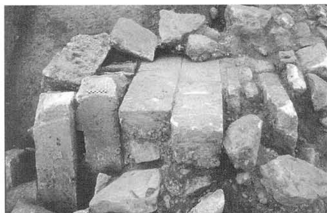
Fig. 34 – ARLES, Abbaye d'Ulmet. Assises en appareil mixte encore liées par le mortier et surmontées de trois corbeaux (à gauche) (M. Charlet).
