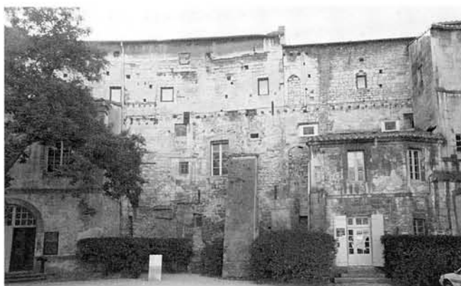
Fig. 33 – ARLES, palais archiépiscopal. Façade nord de l'aile gothique étudiée, cour de l'archevêché.
