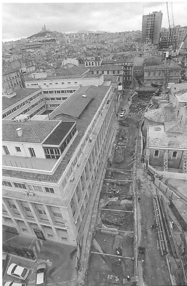
Fig. 44 – MARSEILLE, tunnel de la Major. L'ensemble de l'emprise de fouille depuis le nord (F. Parent, INRAP).
