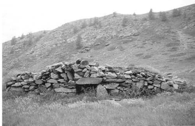
Fig. 19 – FONTAN, stabulation des Conques. Structure A (façade et ouverture très basse, sous un linteau) (H. Geist).
