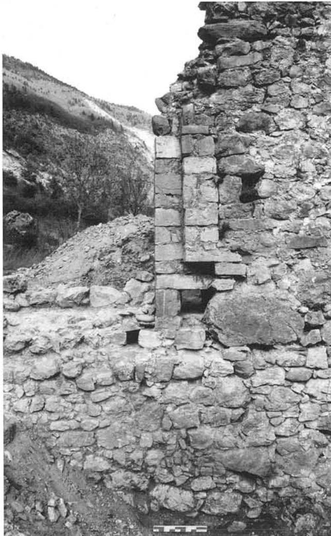
Fig. 26 – LE GLAIZIL, château de Lesdiguières. La porte dégagée, on distingue le trou de poutre dans le pied-droit côté oriental ainsi que l’évacuation du caniveau ; vue prise du sud/sud-est (P. Boucard).
