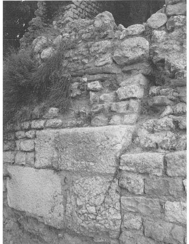
Fig. 57 – NICE, amphithéâtre de Cimiez. Blocs de grand appareil marquant le piédroit d'une première entrée au sud (R. Thernot).
