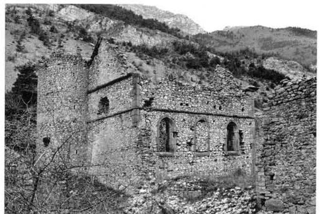
Fig. 25 – LE GLAIZIL, château de Lesdiguières. À droite de la chapelle accolée à la tour sud-ouest, l'emplacement de la baie sud avant intervention : on distingue la base encore en place du piédroit côté est de l'ancienne porte ; vue prise de l'est (P. Boucard).
