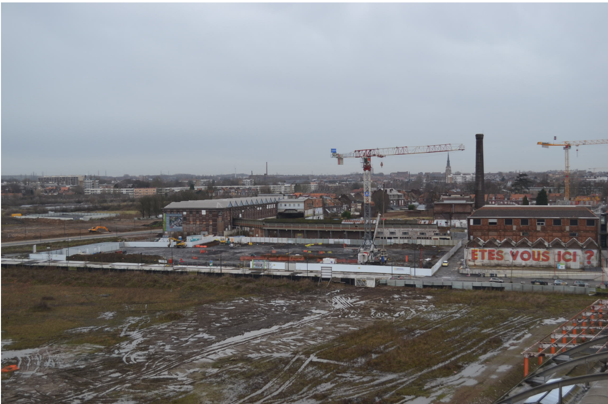
Le chantier de la ruche à l'Union (février 2014) à l'image de l'échelle du site. (c) SEM Ville Renouvelée.
