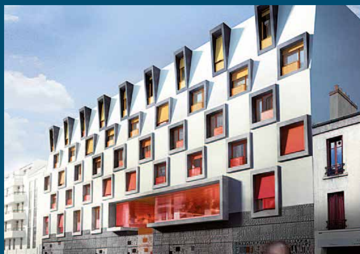
ATELIERS DE MAINTENANCE DE LA LIGNE 9 À BOULOGNE-BILLANCOURT (92) © RATP
