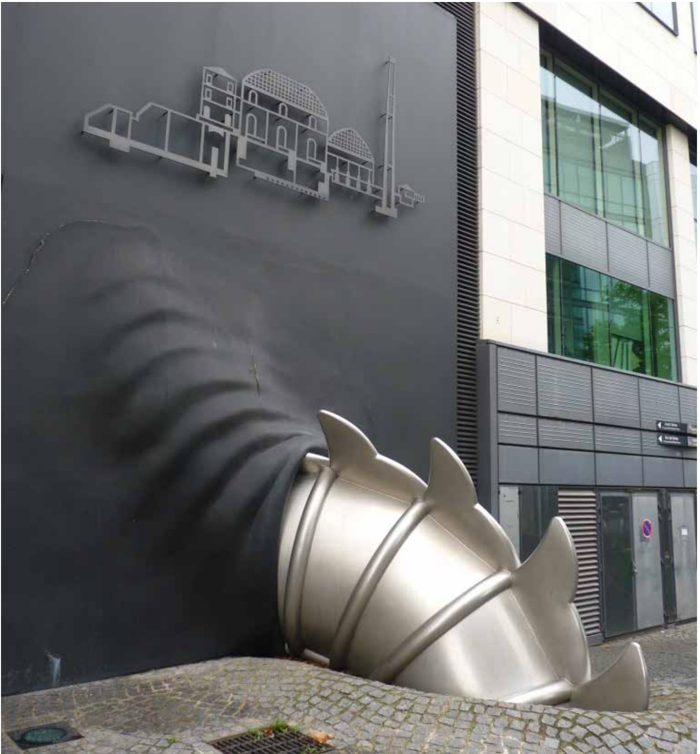
USINE D'AUSTERLITZ © EAU DE PARIS
