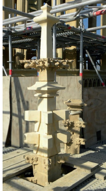
Mise en place d'un pinacle épannelé en pierre neuve avant sa taille.
