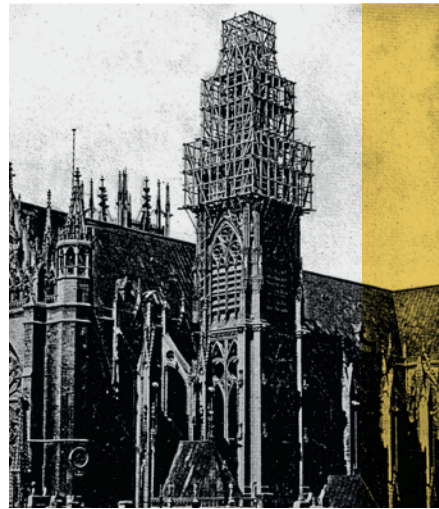
Vue de la flèche échafaudée.
