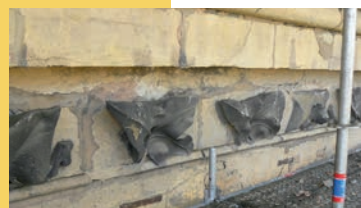
Détail de la frise végétale au niveau 2 de la tour. Avant et après nettoyage.
