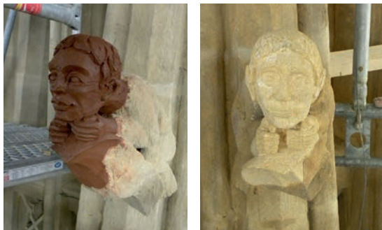
Figure d'homme - en cours de restauration et après. Prototype en terre crue et réalisation en pierre.
