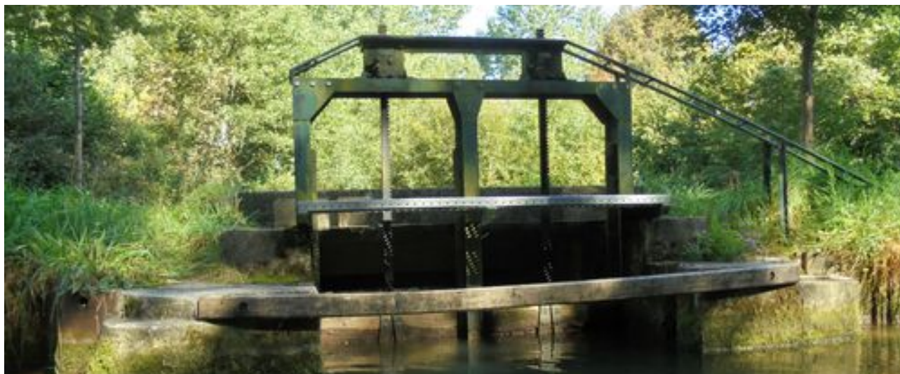
Une écluse sur le canal de l'Ourcq, Crouy-sur-Ourcq
