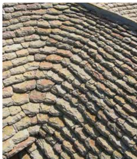
Chanac, château de Ressouches, toiture en lauze de calcaire © STAP de Lozère
