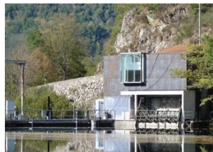
Local de commande EDF au barrage de Campauleil / Orgeix (09) / Olivier Sanchez
