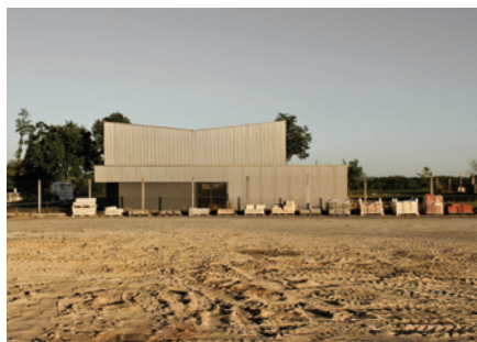
Extension de la déchetterie de la Fouillade / La Fouillade (12) / V2S Architectes
