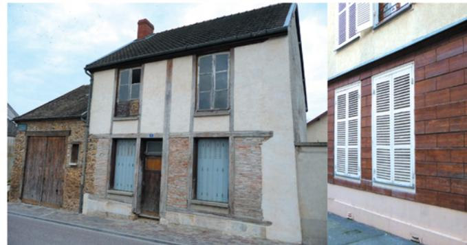
**La structure en pan de bois est rarement apparente.** Elle est le plus souvent cachée par un enduit ou un bardage en bois.
