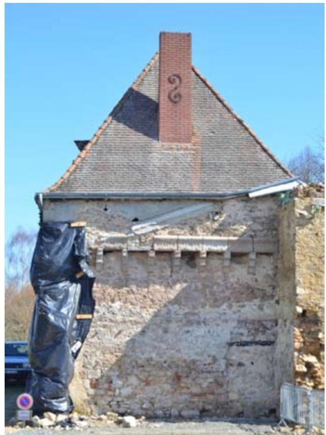
Fig. 2 : façade ouest du pavillon, après démolition des bâtiments qui le masquaient. La bâche protège l'arrachement du mur perpendiculaire du portail d'accès aux boulevards du château. On note que, dans l'ensemble, le système du mâchicoulis décoré a été préservé (cf. P. Conte)
