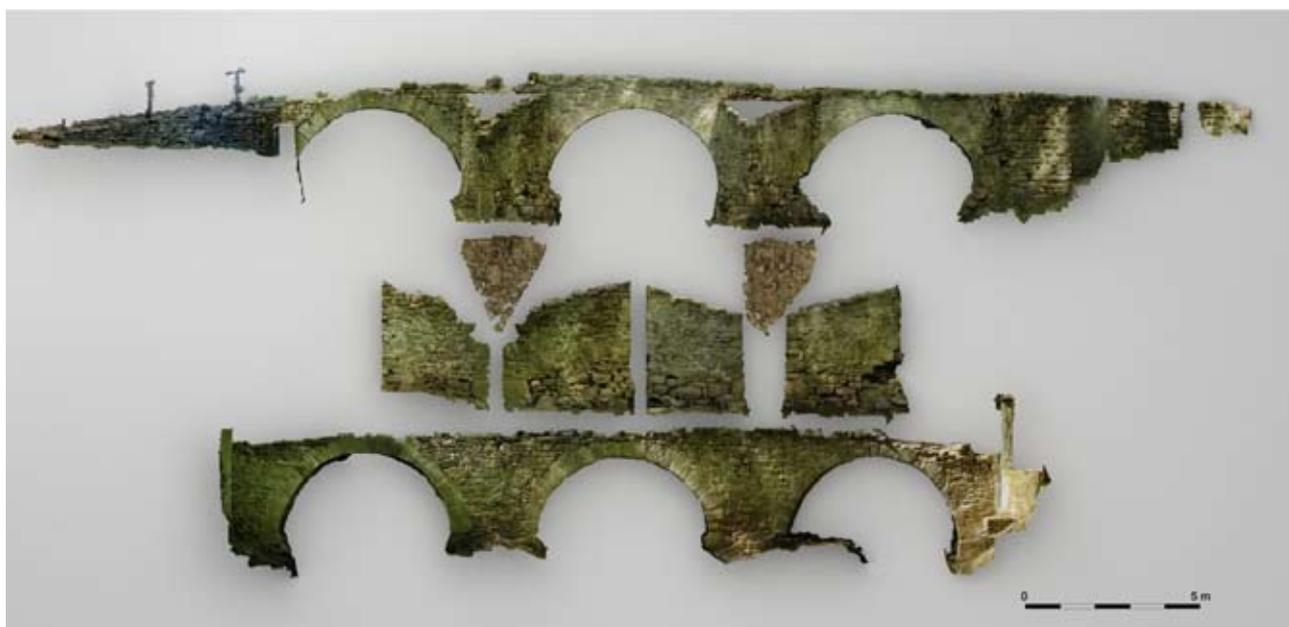
Fig. 1 : photogrammétrie éclatée du pont après nettoyage. De haut en bas : face amont, avant-bec ST 07 et ST 08, face aval. Cl. et mise en page : Nicolas Saulière © Éveha
