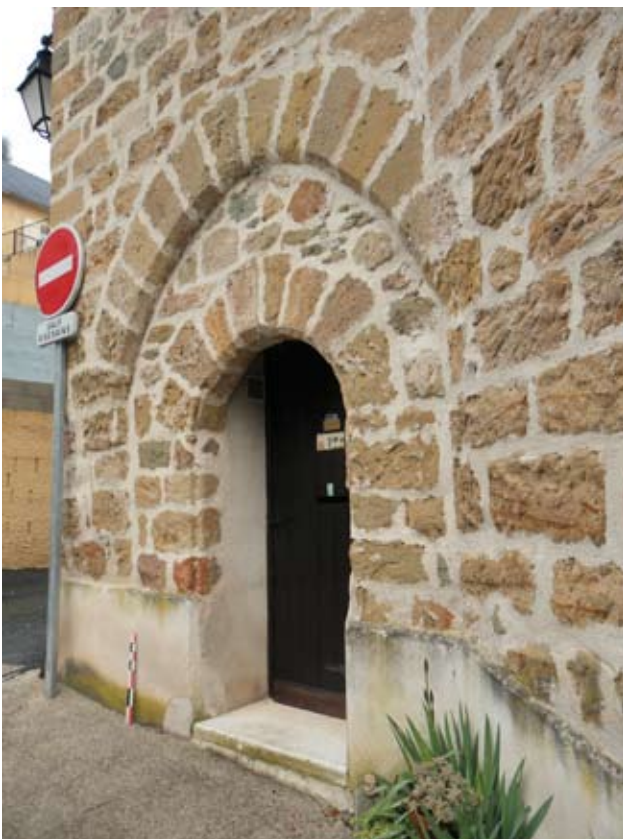
Fig. 4 : portes médiévales du logis de la parcelle 67. Cl. D. Palombas-Odile, Hadès
