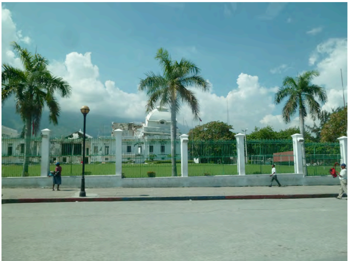
Les ruines du Palais national à Port-au-Prince sont devenues un symbole de la catastrophe. On raconte qu'il ne sera reconstruit que lorsqu'il n'y aura plus personne dans les camps...
