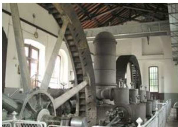
Usine élévatrice de Villers-lès-Rigault
