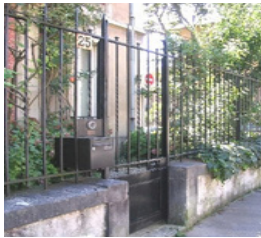
Boîte aux lettres intégrée à la ferronnerie (même matériau et même couleur).
