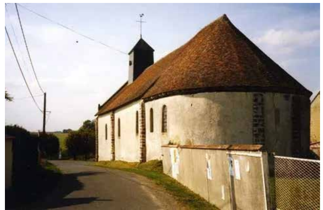
©Mairie de Morvilliers
