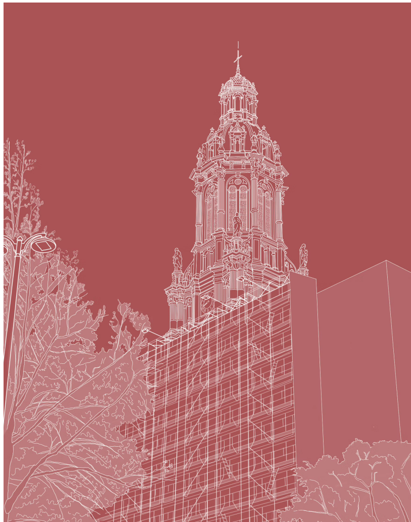
Travaux de restauration de l'église de la Sainte-Trinité, DECH de la Ville de Paris (livraison prévue en 2027)
