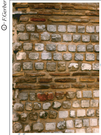
Chaînage horizontal de briques (Evreux)
