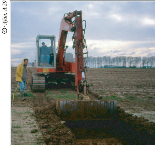
Sondage mécanique en tranchée sur le tracé de l'autoroute A. 29
