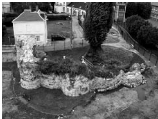
HARFLEUR, La Porte de Rouen : Vue générale des élévations conservées (B. Duvernois)
