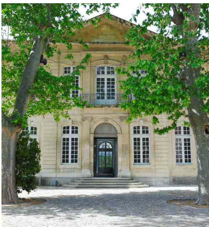
Vue de la cour de l'Hôtel de Caumont, Collection Lambert, 2022
