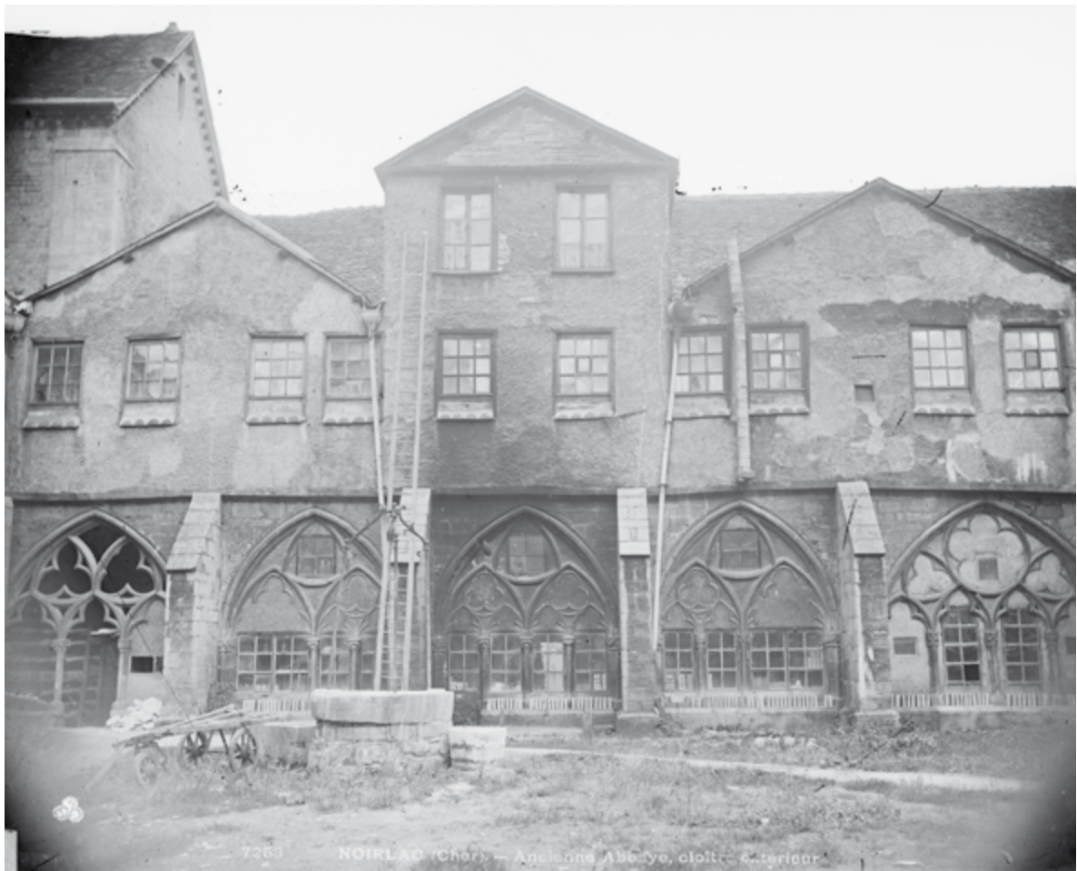
Fig. 4 : Le cloître muré et surmonté d'un étage avant leur suppression d'après une photographie d'Eugène Durand, actif de 1876 à 1917 (Ministère de la Culture - Médiathèque de l'architecture et du patrimoine - diffusion RMN).
