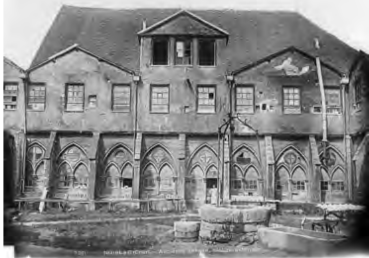
Fig. 4 : La façade ouest de l'église abbatiale où l'on distingue la galerie du cloître murée et surmontée d'un étage, d'après une photographie d'Eugène Durand, actif de 1876 à 1917 (Ministère de la Culture (France) – Médiathèque de l'architecture et du patrimoine – diffusion RMN).
