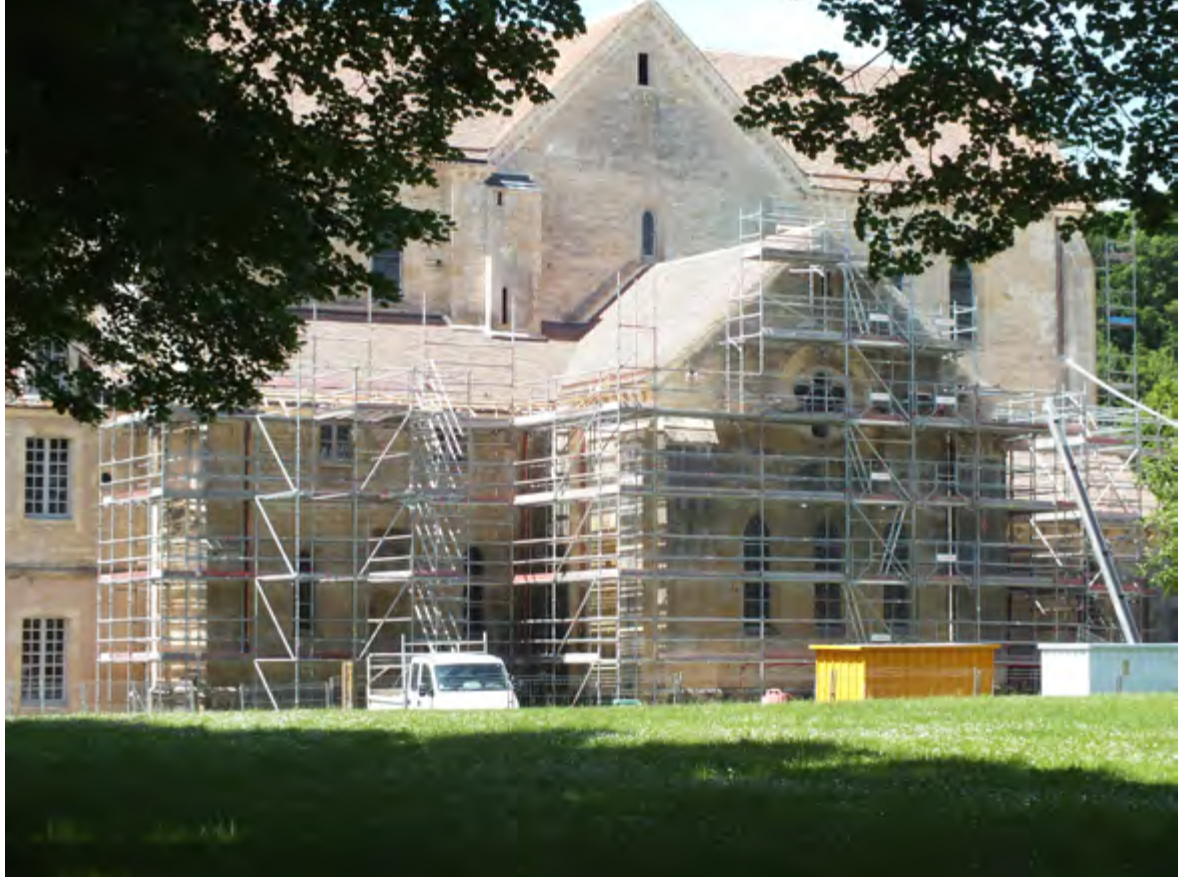
Fig. 7 : Travaux de restauration des couvertures effectués en 2017 © P. Poulle, Inrap.
