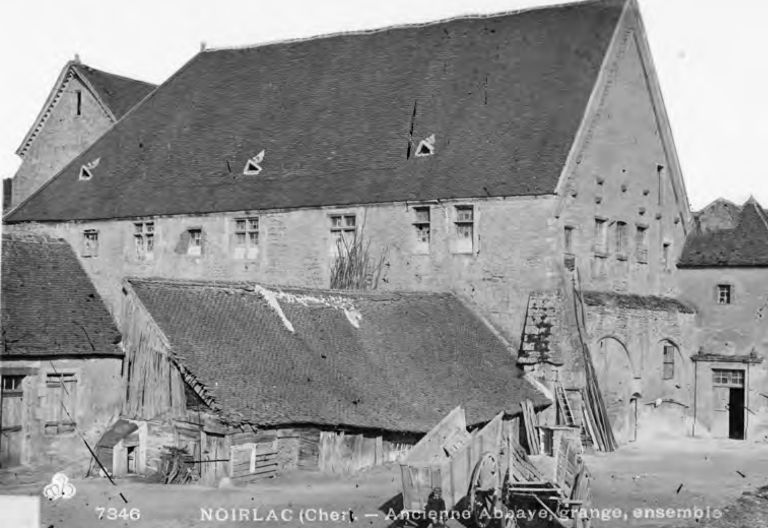
Fig. 3 : Des granges accolées aux bâtiments conventuels avant leur suppression d'après une photographie d'Eugène Durand, actif de 1876 à 1917 (Ministère de la Culture - Médiathèque de l'architecture et du patrimoine - diffusion RMN).
