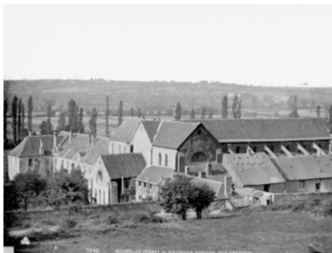
Fig. 3 : Les bâtiments abritant les fours, accolés au mur nord de l'église abbatiale, d'après une photographie d'Eugène Durand, actif de 1876 à 1917 (Ministère de la Culture (France) – Médiathèque de l'architecture et du patrimoine – diffusion RMN).
