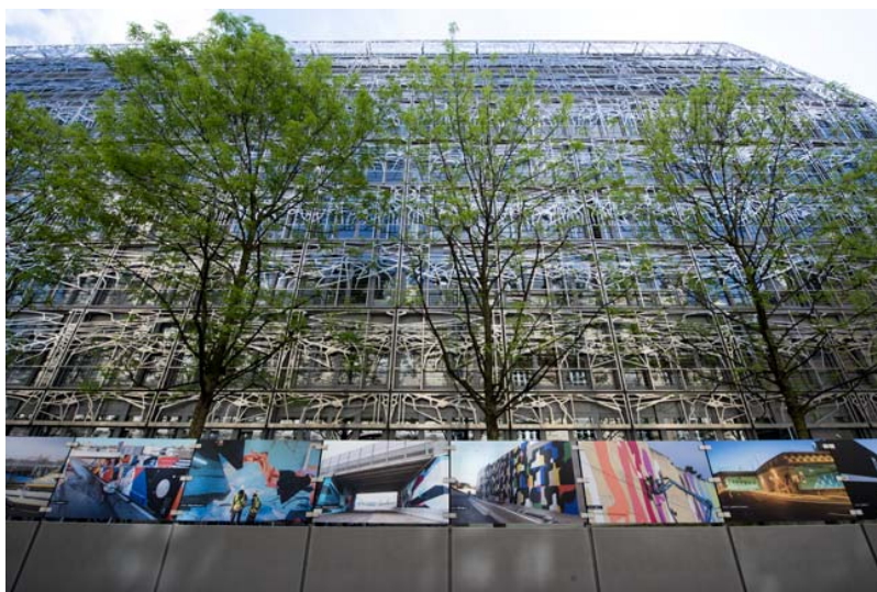
Vue de l'exposition À l'échelle de la ville ! Arts et aménagements des territoires sur les façades du ministère de la Culture © Didier Plowy
