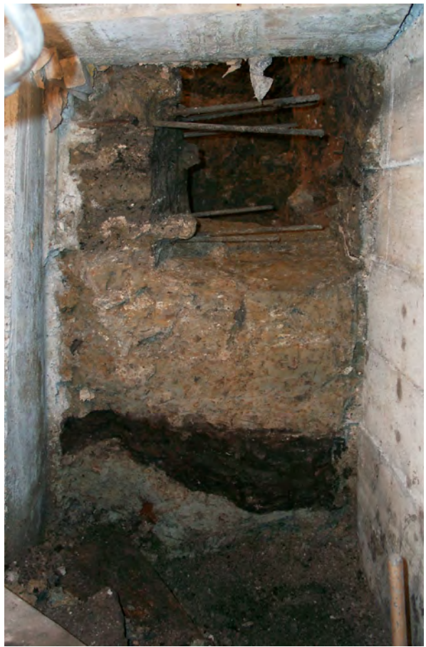
Reprise en sous-œuvre des fondations et fers en attente © Inrap.
