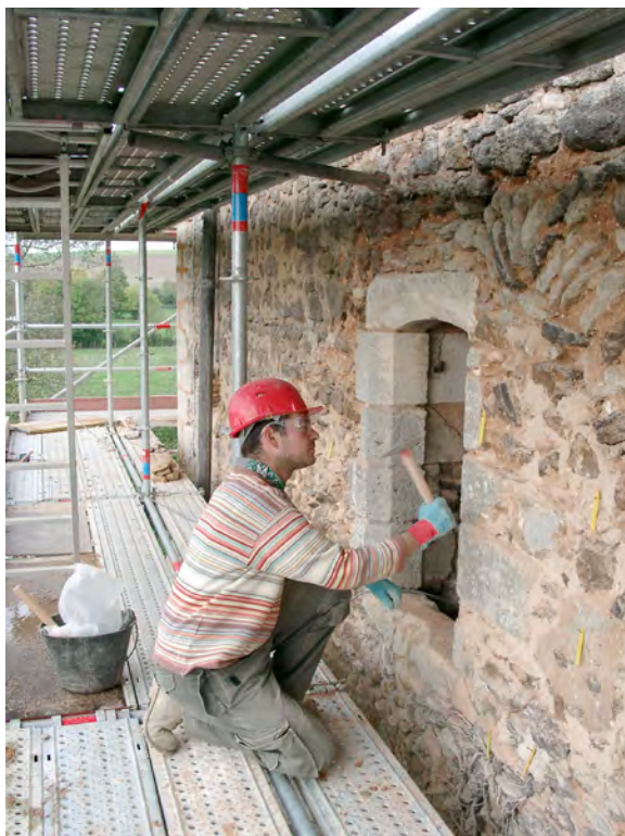
Fouille des maçonneries par piquetage © Inrap.
