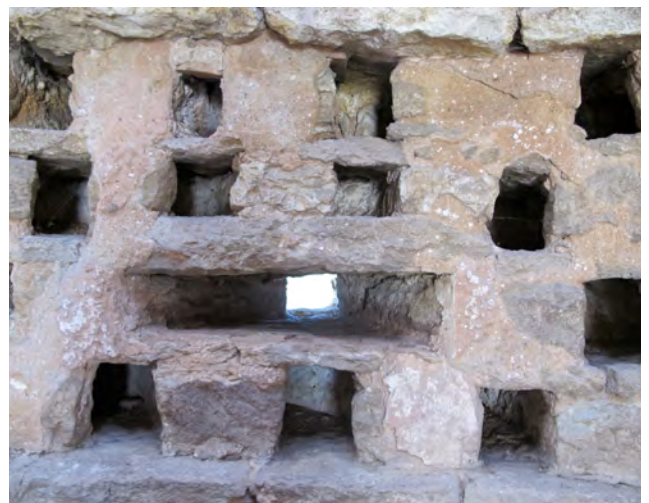
Juxtaposition de l'embrasure intérieure d'une canonnière et des boulins de pigeons © Inrap.
