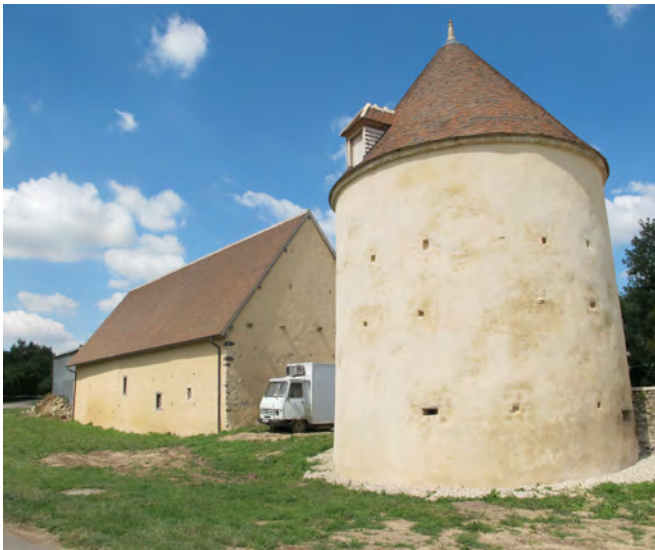
Grange et colombier après restauration © Inrap.
