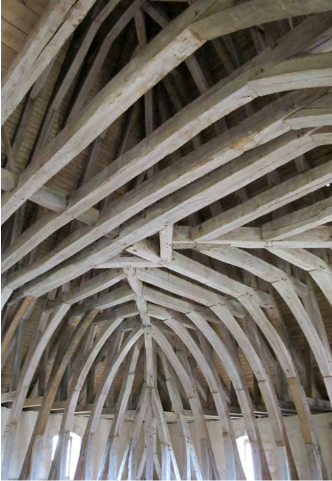
Vue de détail sur la charpente de la tour © Inrap.
