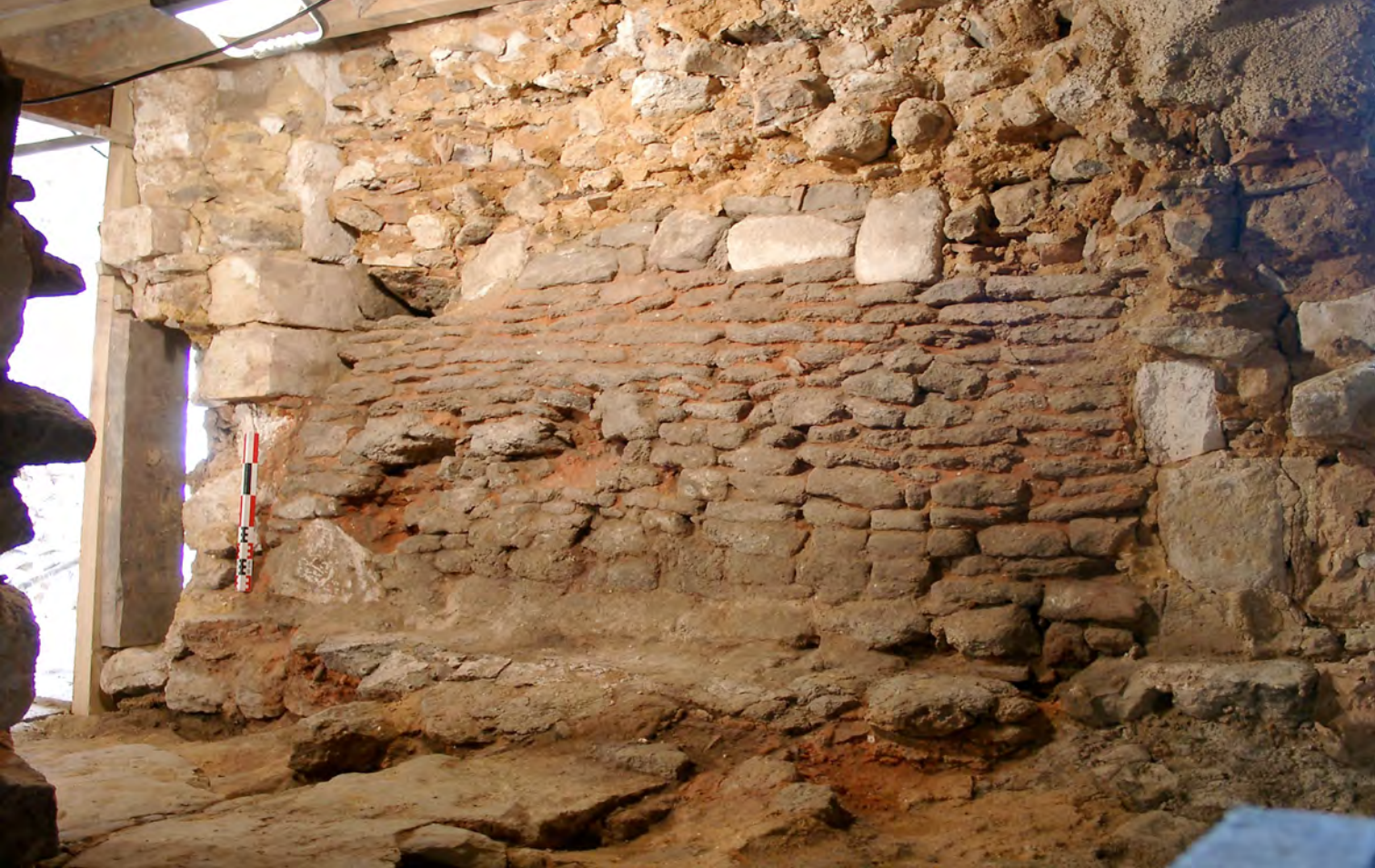
Cheminée du rez-de-chaussée de la tour © Inrap.
