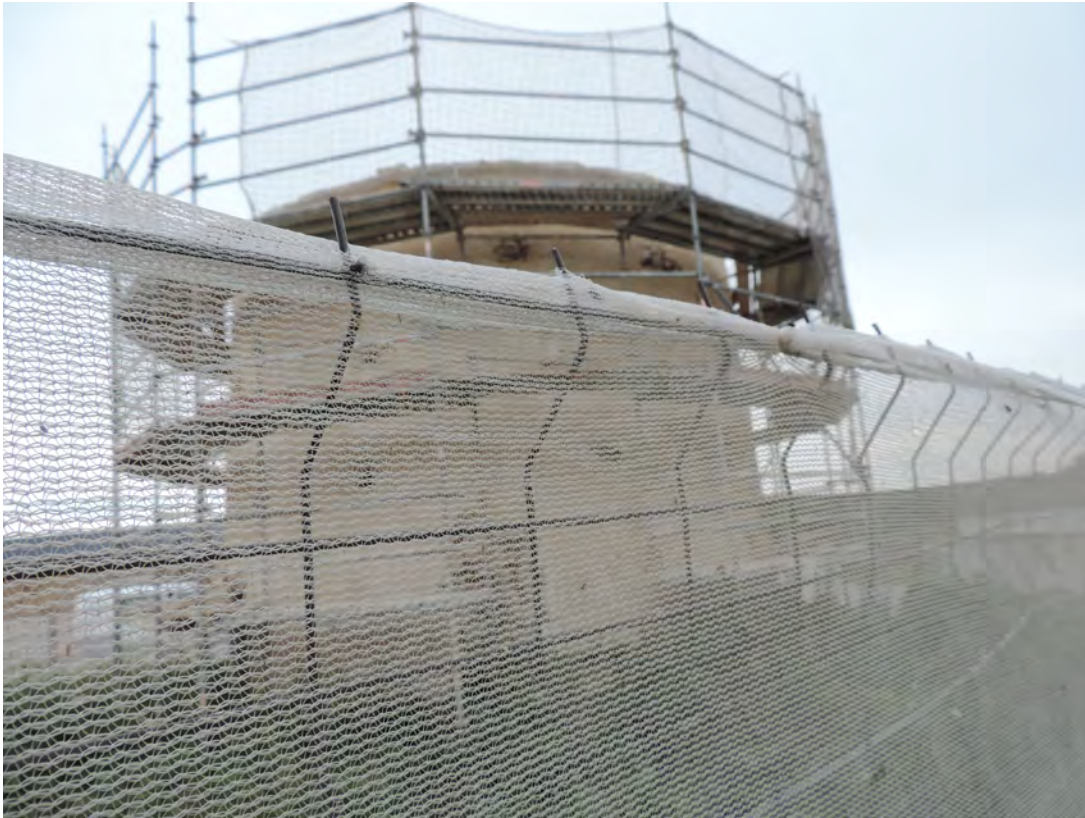
Grillages du chantier de restauration du colombier en 2014 © Inrap.
