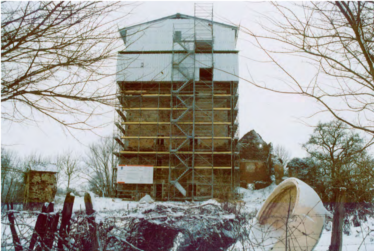
Échafaudage 1998 : premier volet de restauration de la tour © Inrap.
