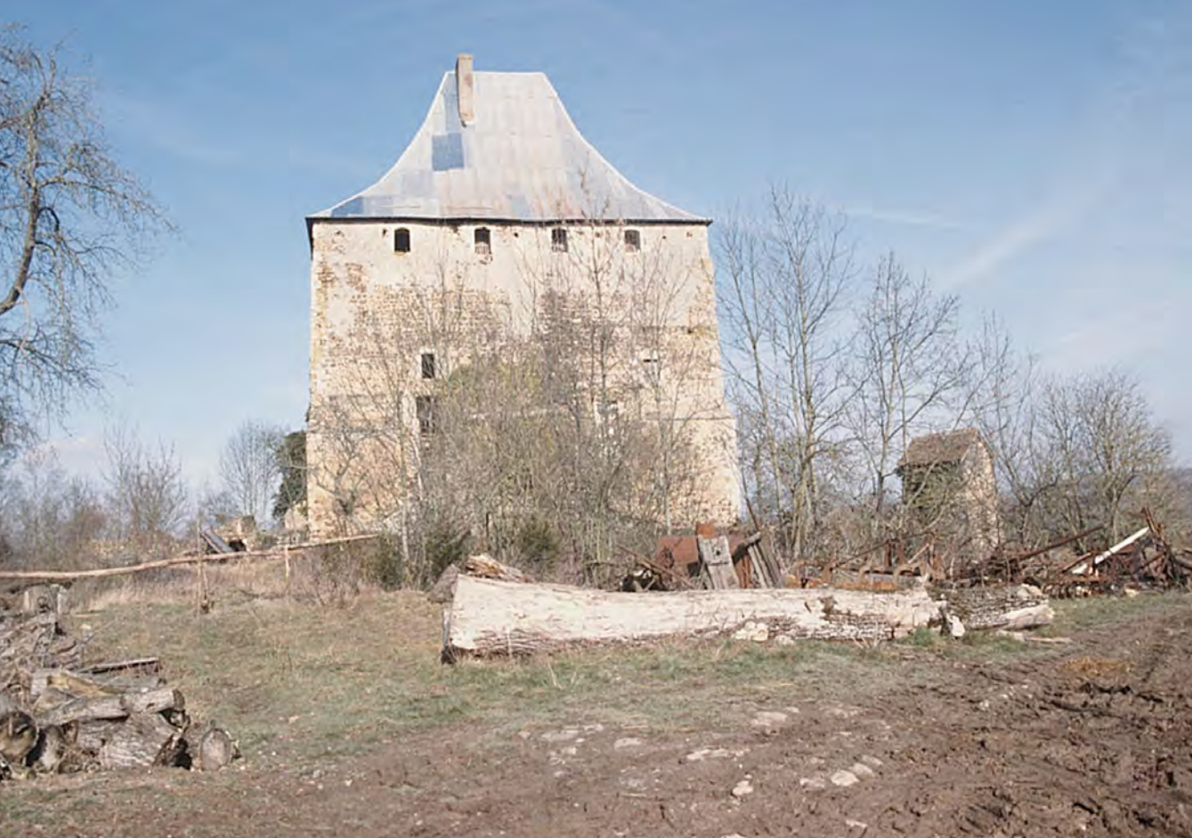
État d'abandon du site © DRAC Centre-VdL - CRMH - Anne-Isabelle Berchon.
