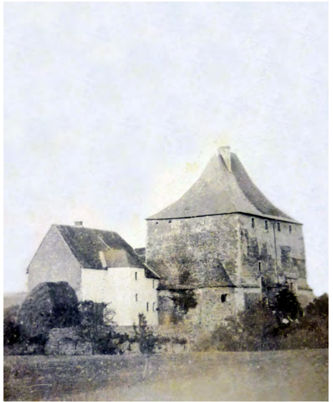
Face avant du logis en septembre 1884, archive inédite, Pierre de Goy, Société des Antiquaires du Centre, AD du Cher, cote 0002 F 00720.
