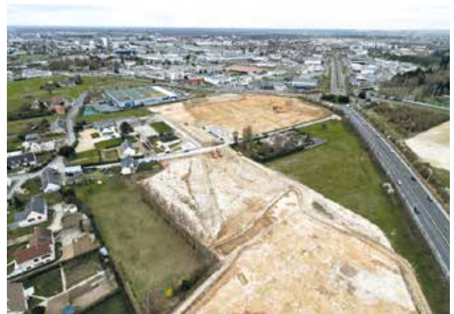
Tours, vue aérienne des fouilles réalisée dans le cadre de l'aménagement de la première ligne de tramway.
