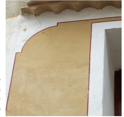
exemple d'un décor à l'enduit qui reproduit les éléments décoratifs traditionnels : entourage de baie et chaînage
