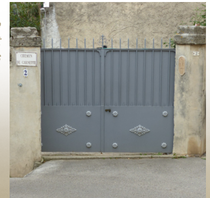
exemple de portail sur cour, l'obstruction de la partie haute (pour la visibilité) est envisageable dans certains cas
