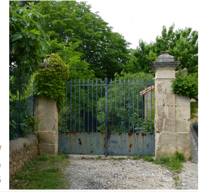
exemple d'un portail ouvragé, sur le jardin d'une grande propriété
