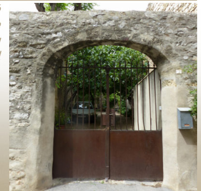
exemple d'un portail percé dans un mur ; malgré l'anse de panier, le dessin du portail reste orthogonal
