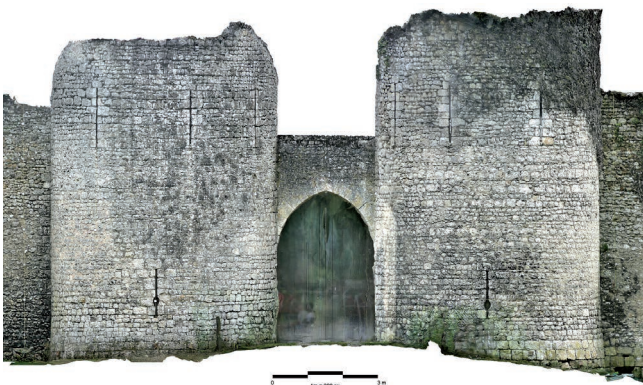
Fig 3 : Dordives (Loiret) château de Mez-le-Maréchal : orthophotographie de la porte à deux tours - façade nord (Les Amis du Mez)
