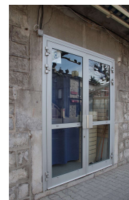
✗ Devanture posée au nu de la façade A PROSCRIRE
