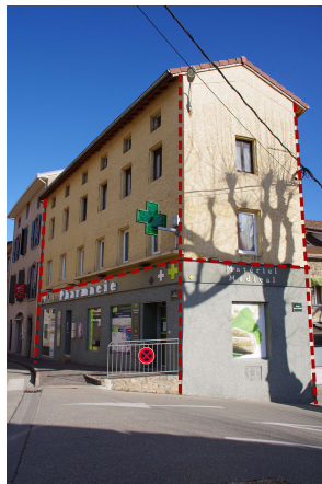
Rez-de-chaussée commercial (Satillieu)
