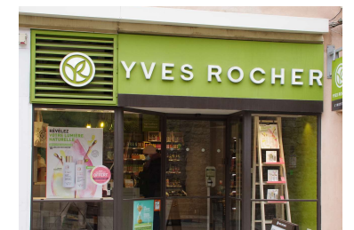
Grille de ventilation dissimulé dans le bandeau de la devanture (Aubenas)
