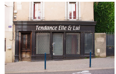
Grilles ajourées - mécanisme dissimulé dans le bandeau (Annonay)
