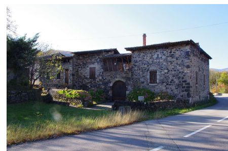
Mur bas en pierres sèches (Montpezat sous Bauzon)
