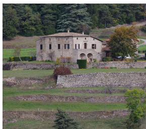
Mur de soutènement en pierres sèches A RÉALISER
