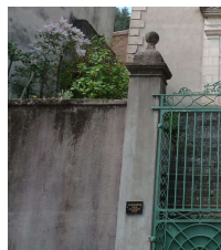
Mur en pierres enduit (Vals les Bains)
