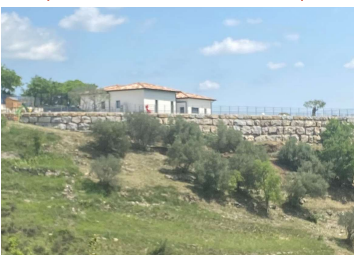
Mur de soutènement en enrochement cyclopéen A PROSCRIRE
