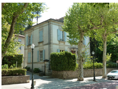
Mur bas en pierres rejointoyées doublé de végétal (Vals les Bains)
