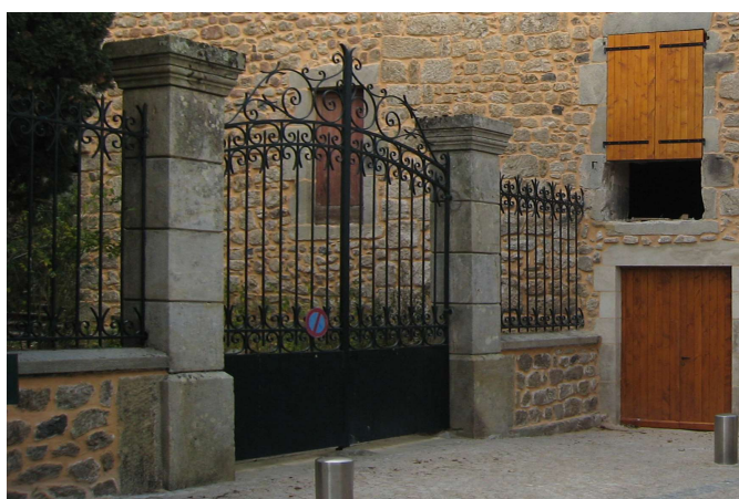
Grille de clôture et portail (Meyras)
